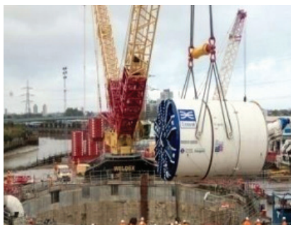
Fig.2 - Movimentação mecânica de cabeça de tuneladora em poço
