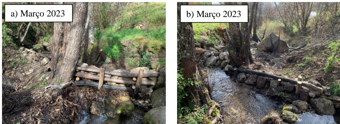
Figura 46. Local de monitorização 5 na 1ª visita em março de 2023, após a implementação da medida de estabilização de emergência: a) vista a jusante da OCT; b) vista a montante da OCT
