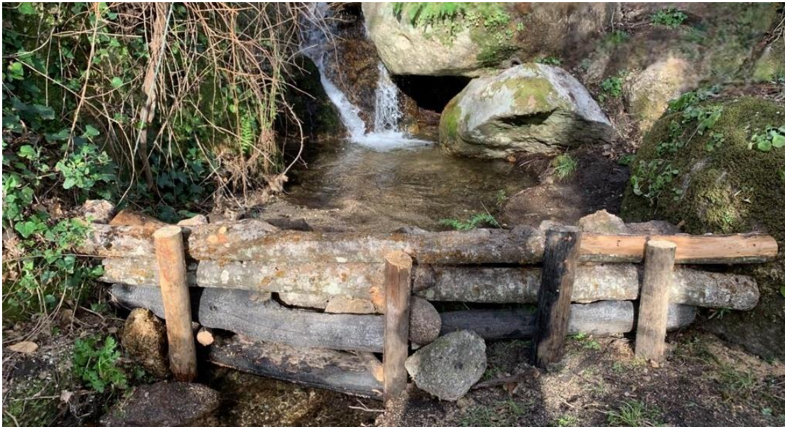
Figura 36. Obra de correção torrencial em linha de água perene
