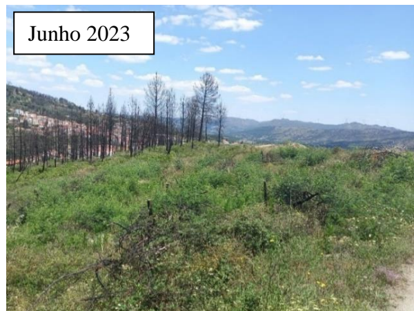
Figura 52. Local de monitorização 6 na 2ª visita em junho de 2023, após a implementação da medida de estabilização de emergência
