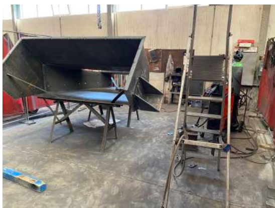
(a) Posto de trabalho Soldadura
