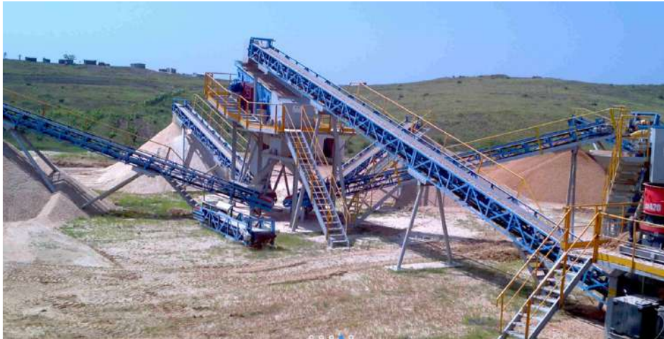
Figura 9: Instalação Completa - meter cidade
