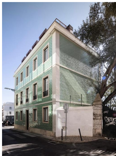
Figura 9 | Vista Sobre Fachada Frontal
