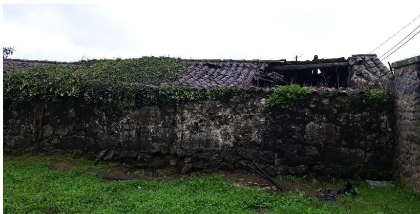
Figura 71 | Vista Sobre Fachada Norte
