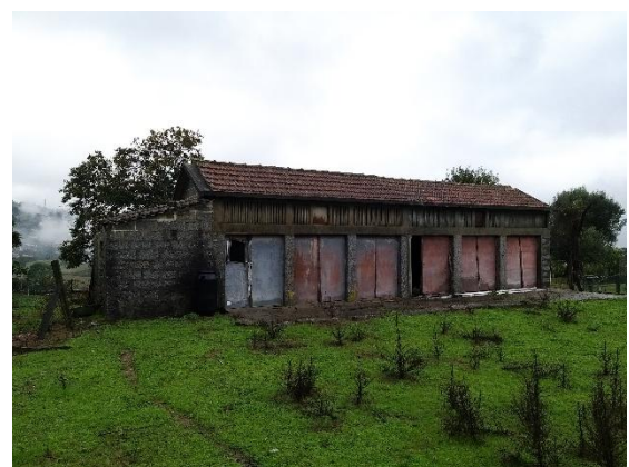
Figura 74 | Vista Sobre Fachada Este
