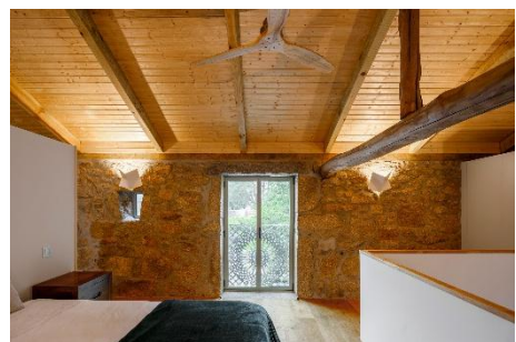
Figura 4 | Cobertura de Madeira Aparente
