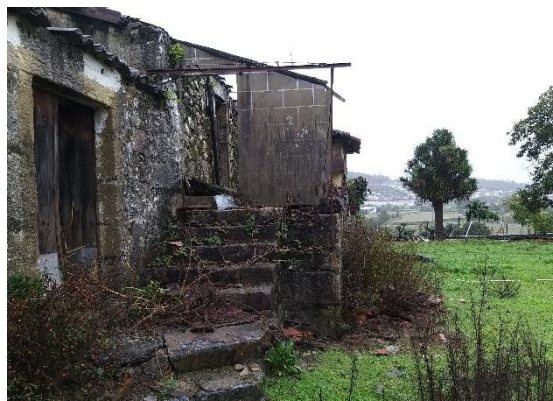
Figura 68 | Escadaria de Acesso Piso Superior
