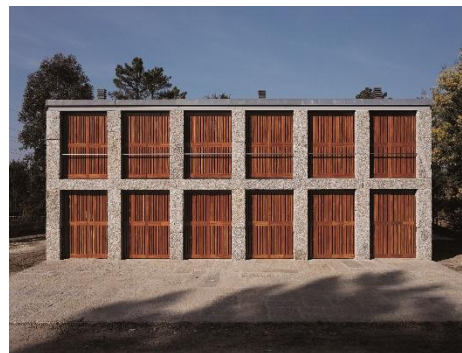
Figura 32 | Fachada Frontal (Portadas Fechadas)
