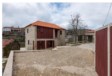
Figura 39 | Vista Exterior - Ripado de Madeira
