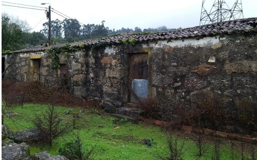
Figura 69 | Vista Sobre Fachada Sul
