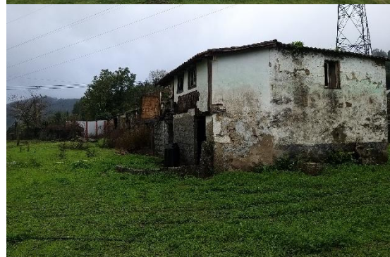
Figura 66 | Vista Sobre Fachada Este e Sul
