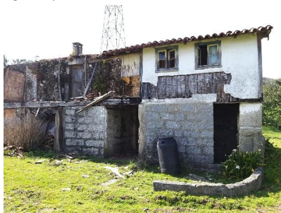
Figura 67 | Vista Sobre Fachada Sul
