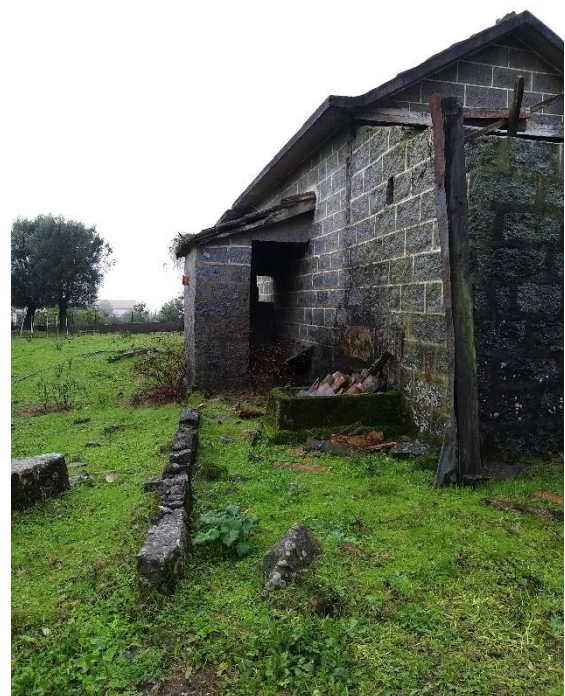
Figura 73 | Vista Sobre Entrada de Anexo Lado Oeste
