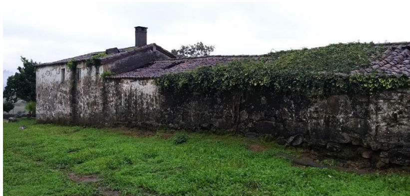
Figura 70 | Vista Sobre Fachada Norte
