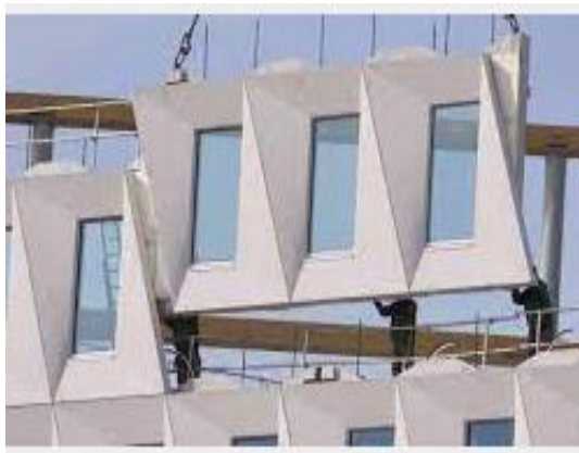
Figura 5 – Fachada modular em Betão e Madeira, respetivamente
