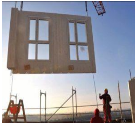
Figura 5 – Fachada modular em Betão e Madeira, respetivamente
