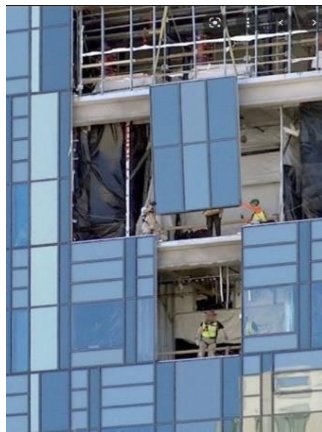
Figura 6 - Fachada Modular em Aço, Alumínio e Combinação, respetivamente
