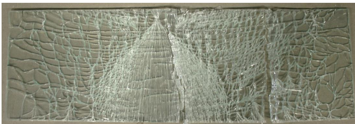
Figura 87 – Padrão de fendilhação após rotura do provete P5.
