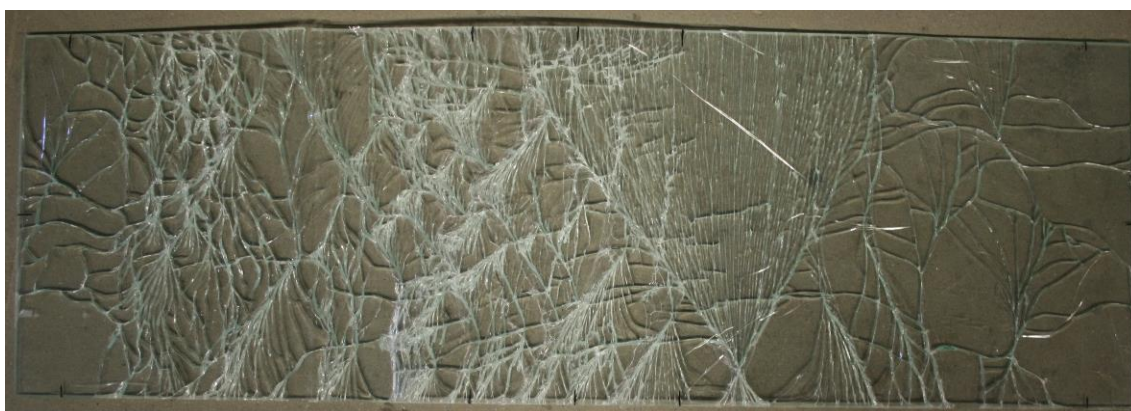
Figura 84 – Padrão de fendilhação após rotura do provete P2.
