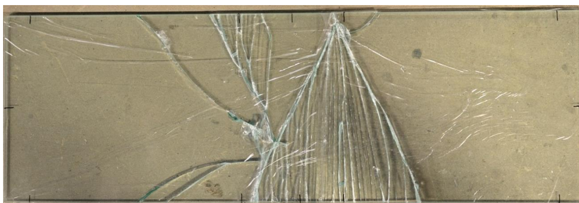
Figura 90 – Padrão de fendilhação após rotura do provete P8.
