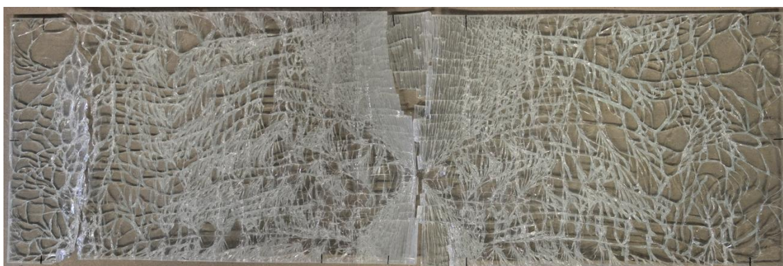
Figura 88 – Padrão de fendilhação após rotura do provete P6.
