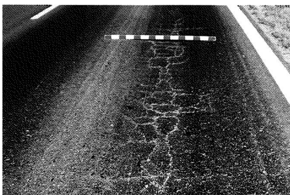
Pele de crocodilo - nível 3 (LCPC)
