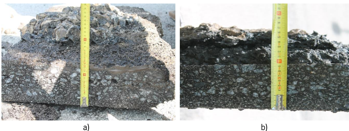
Figura 37 – Amostra das camadas betuminosas extraídas dos poços de sondagem: a) poço 1; b) poço 2
