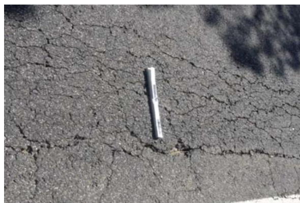
Pele de crocodilo - nível 3 (IP)
