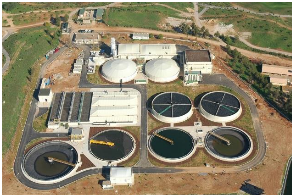
Figura 16: Vista aérea da ETAR de Vilamoura (Fonte: Águas de Portugal)
