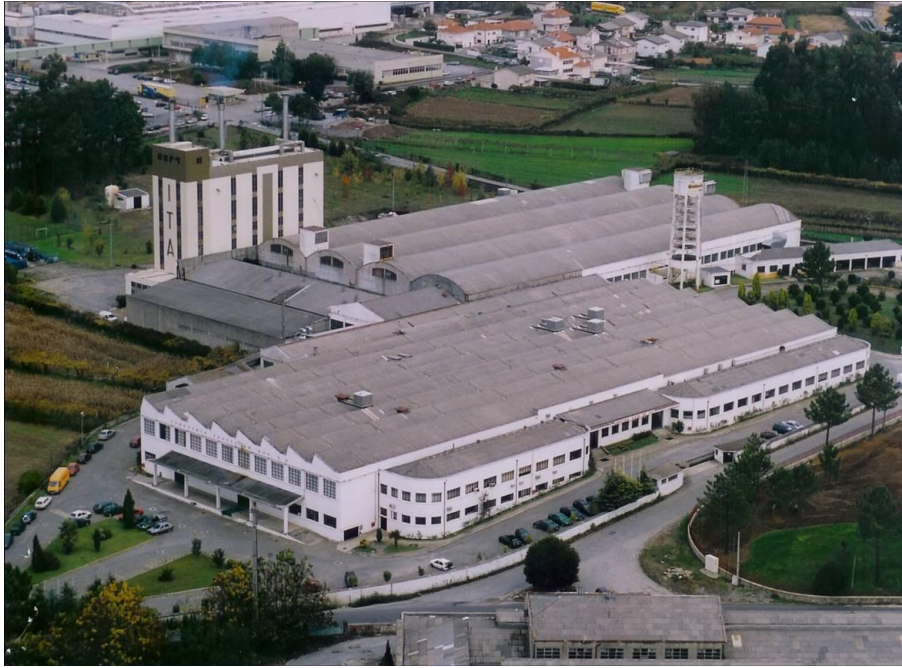
Figure 1.1: Continental – Indústria Têxtil do Ave. S.A. (C-ITA), located in Lousado, Vila Nova de Famalicão.
