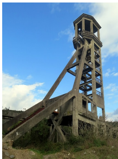
Figura 18: Cavalete do Poço de São Vicente em S. Pedro da Cova.
