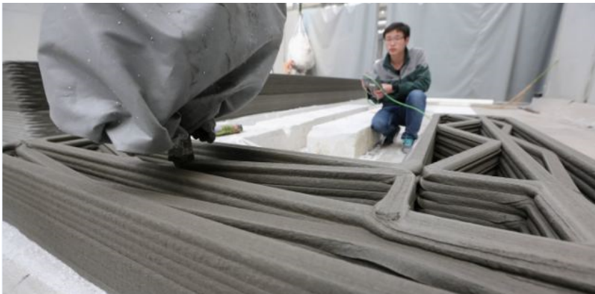
Figura 2.1.f. - Fabrico de um componente estrutural de uma casa, Winsun3D, 2014.
