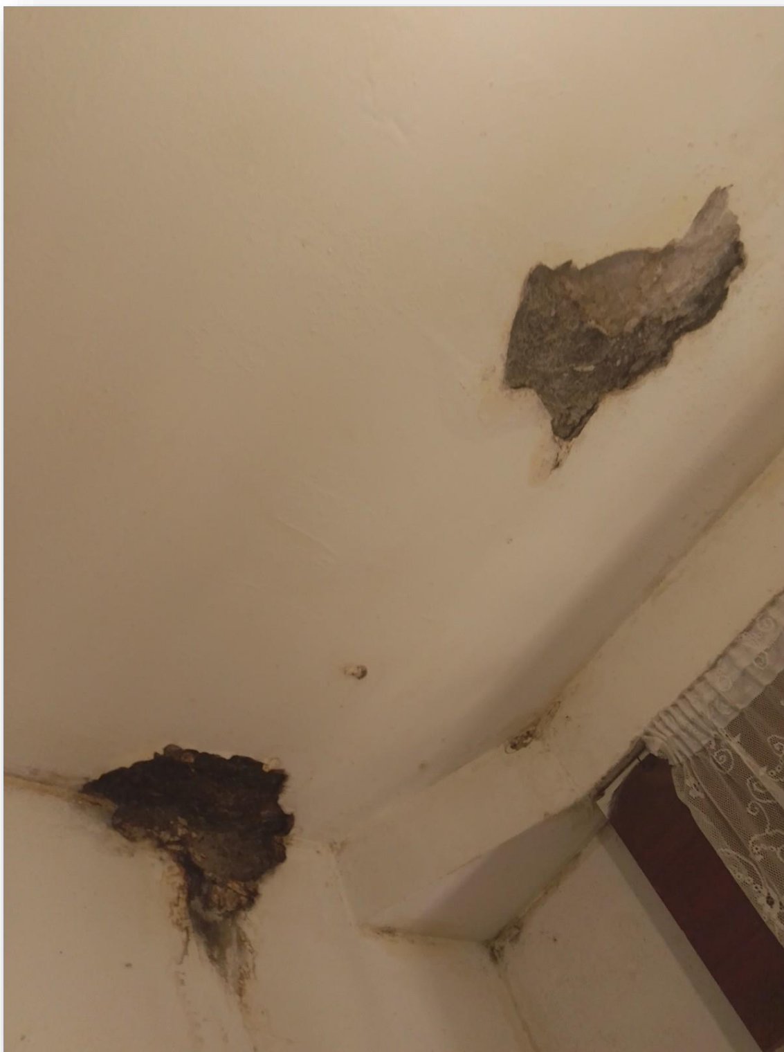
Fotografia 19 - Teto da cozinha
