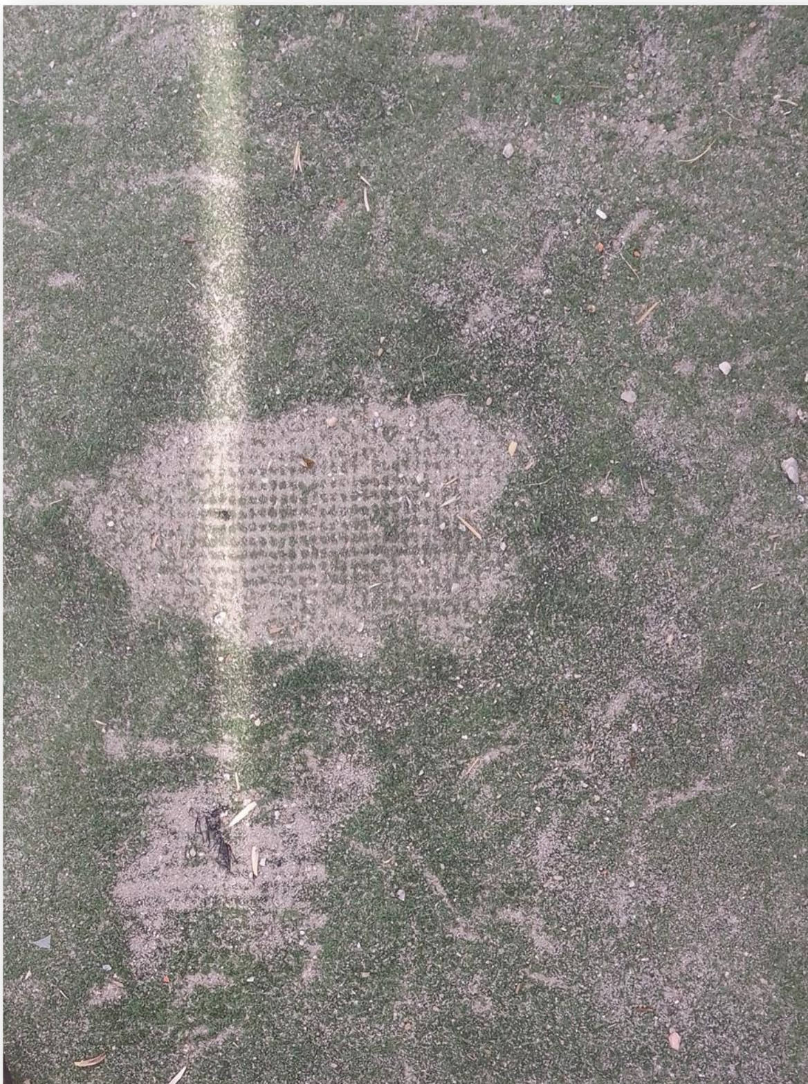
Fotografia 13 - Piso degradado
