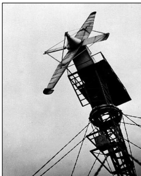
Figura 1 - Turbina de Gedser
