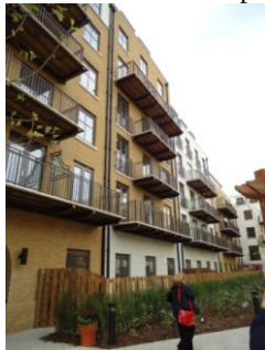
Vista das fachadas no interior do empreendimento
