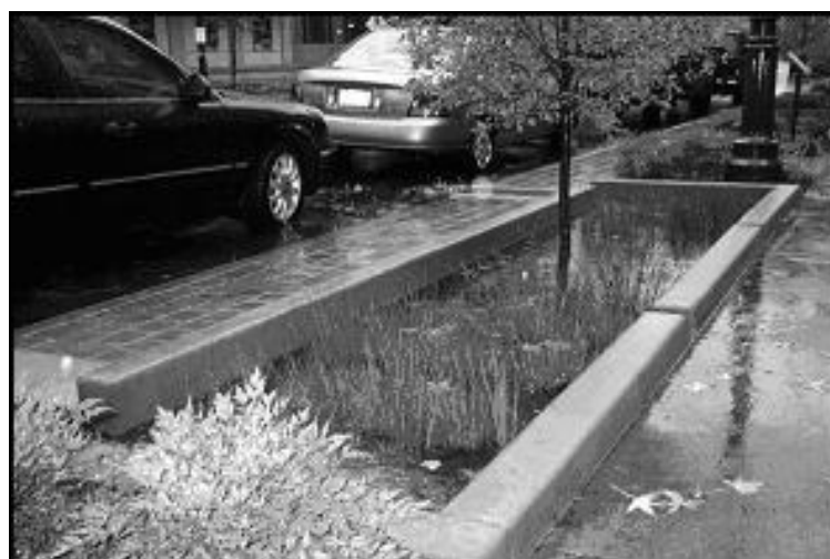
Figura 3 - Detalhe da canaleta captando as águas pluviais recentemente precipitadas, Portland, Oregon
