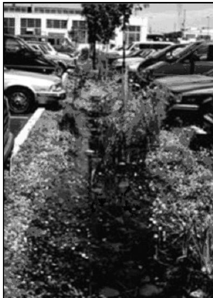
Figura 6 - Vista biovaleta e o escoamento das águas colhidas
