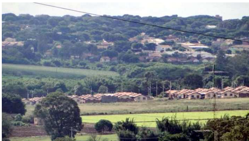
Fig. 6 Conjunto Habitacional Mauá em Sarandi
