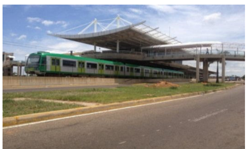
Fig. 9 Estación Altos de la Vanega
