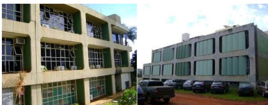
Fig. 2 – Fachadas Norte do bloco A (à esquerda) e bloco B (à direita).
