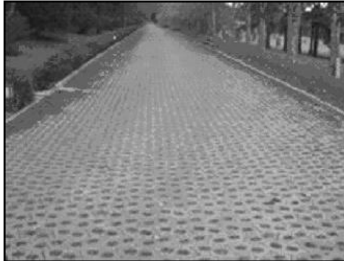
Figura 7 - Exemplo de pavimentos porosos: concregrama e pavigreen Fonte: PACHECO, 2009.
