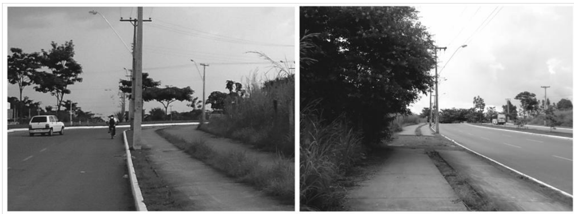
Fig. 5 – Ciclista trafegando fora da ciclovia, falta de sombreamento e continuidade.
