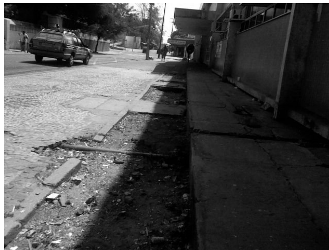
Fig. 07 Calçada no Trecho 03. Fonte: Nestor Castro (2011)
