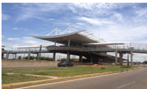
Fig.10 Estación Altos de la Vanega
