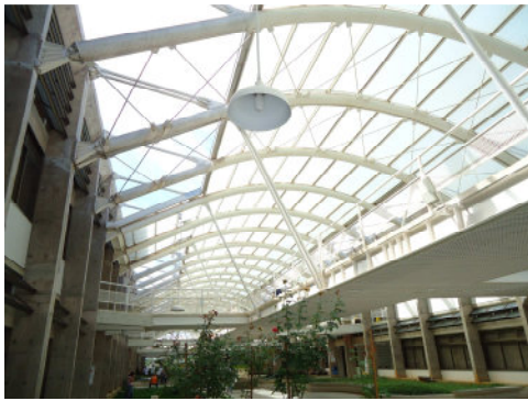
Figura 7 – Pátio interno do Instituto de Química
