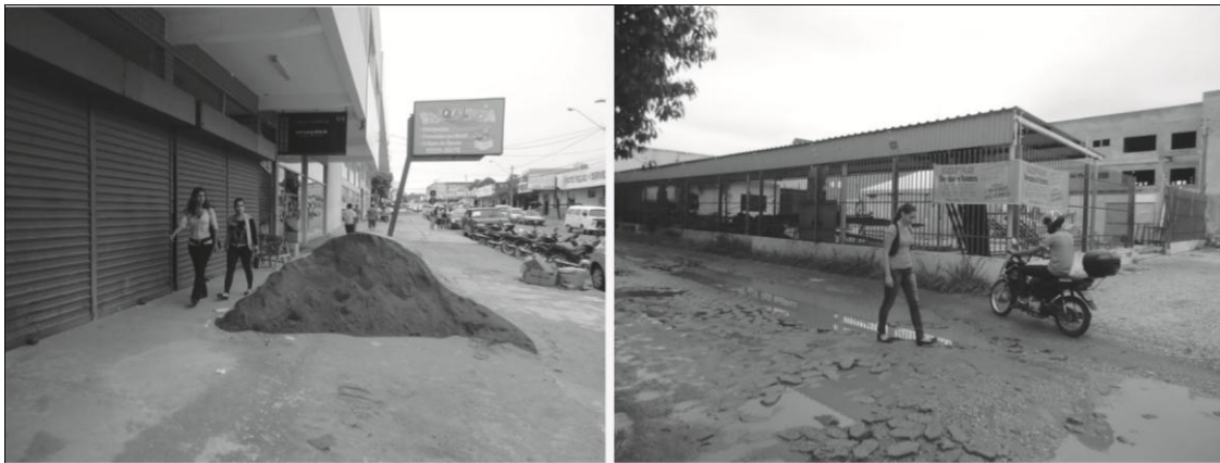
Fig. 6 - Foto dos passeios em Palmas sem calçamento, arborização, iluminação pública, além da presença de entulho e buracos.
