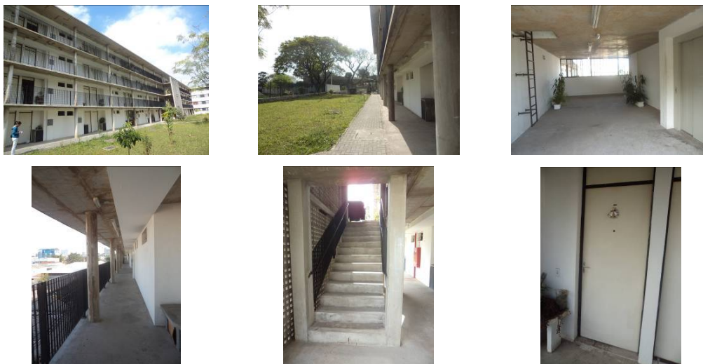
Fig. 4 a,b,c,d,e,f : Acessos à edificação, acesso ao elevador, circulação, escada e acesso ao apartamento.
