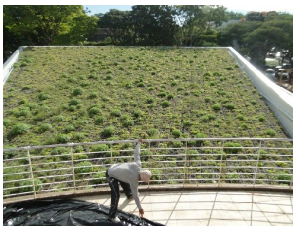
Fig. 2 Telhado verde em novo prédio de salas de aula (UFU, 2012)
