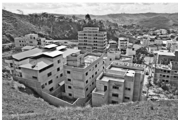
Fig. 2 Vista do bairro Liberdade, evidenciando os prédios ainda em construção.
