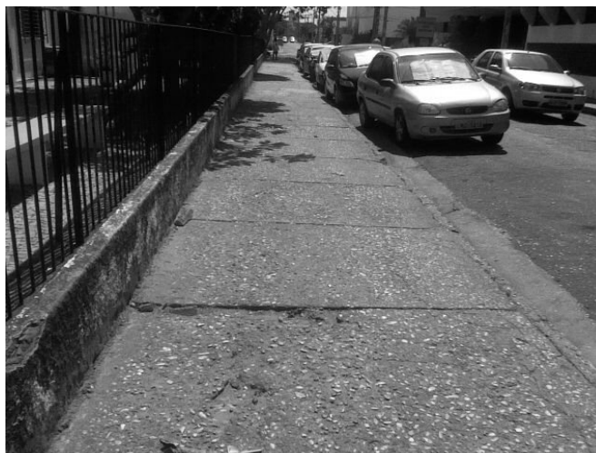
Fig. 08 Calçada no Trecho 04 – Facime. Fonte: Nestor Castro (2011)
