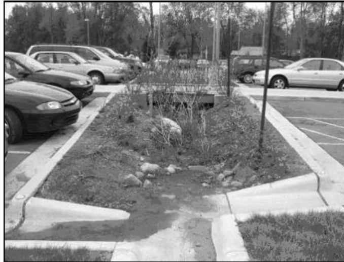
Figura 5 - Vista de estacionamento com coletores para as águas pluviais
