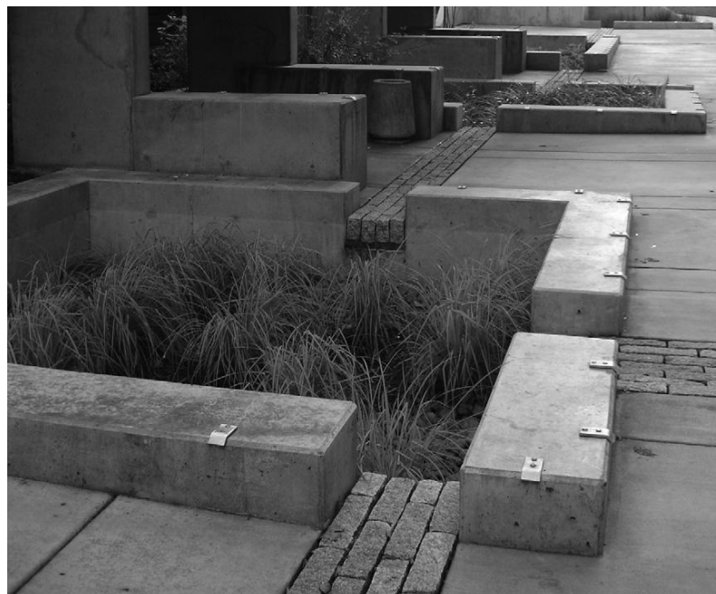
Figura 5: Estrutura de infiltração localizada no campus da University Portland State, EUA.
