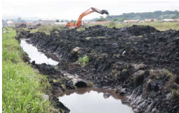
Fig. 3 Obras de rebaixamento do lençol freático no Guarituba
