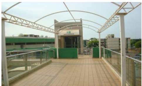
Fig. 8 Estación Altos de la Vanega
