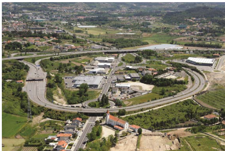
Fig. 1 Vista geral do nó de acesso, a partir da área de intervenção (à esquerda da EN206), Parque da Veiga do Creixomil e Guimarães no horizonte
