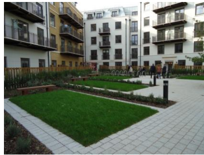
Interior do empreendimento: áreas livres e edifícios
