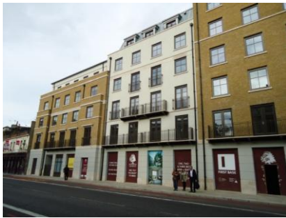
Fachada externa e acesso ao empreendimento
