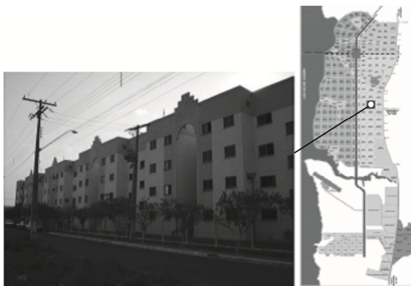
Fig 2 – Tipologias arquitetônica do PAR, na quadra 706 Sul, a cerca de 6 KM da Av. JK. Fonte: MELO JUNIOR (2008, p. 100).
