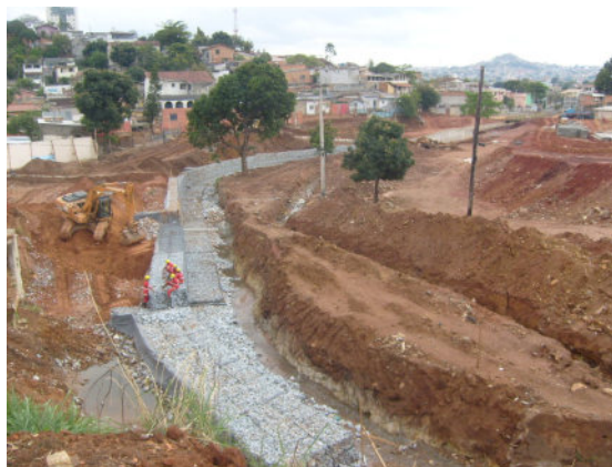
Fig. 6 Reestruturação da calha do Córrego do Navio
