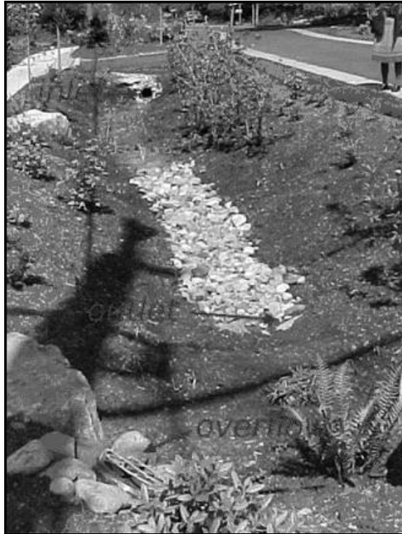
Figura 4 - Biovaleta indicando a entrada, permanência (infiltração) e saída (transbordamento) das águas
