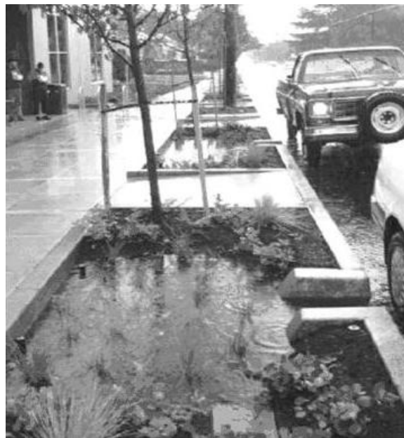
Figura 1 - Caneleta em células recebendo águas pluviais em Seattle
