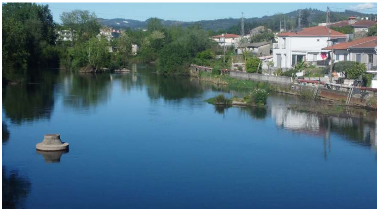
Figura 44 - P3: Formação de bancos de areias a montante. Fonte: Autor.
