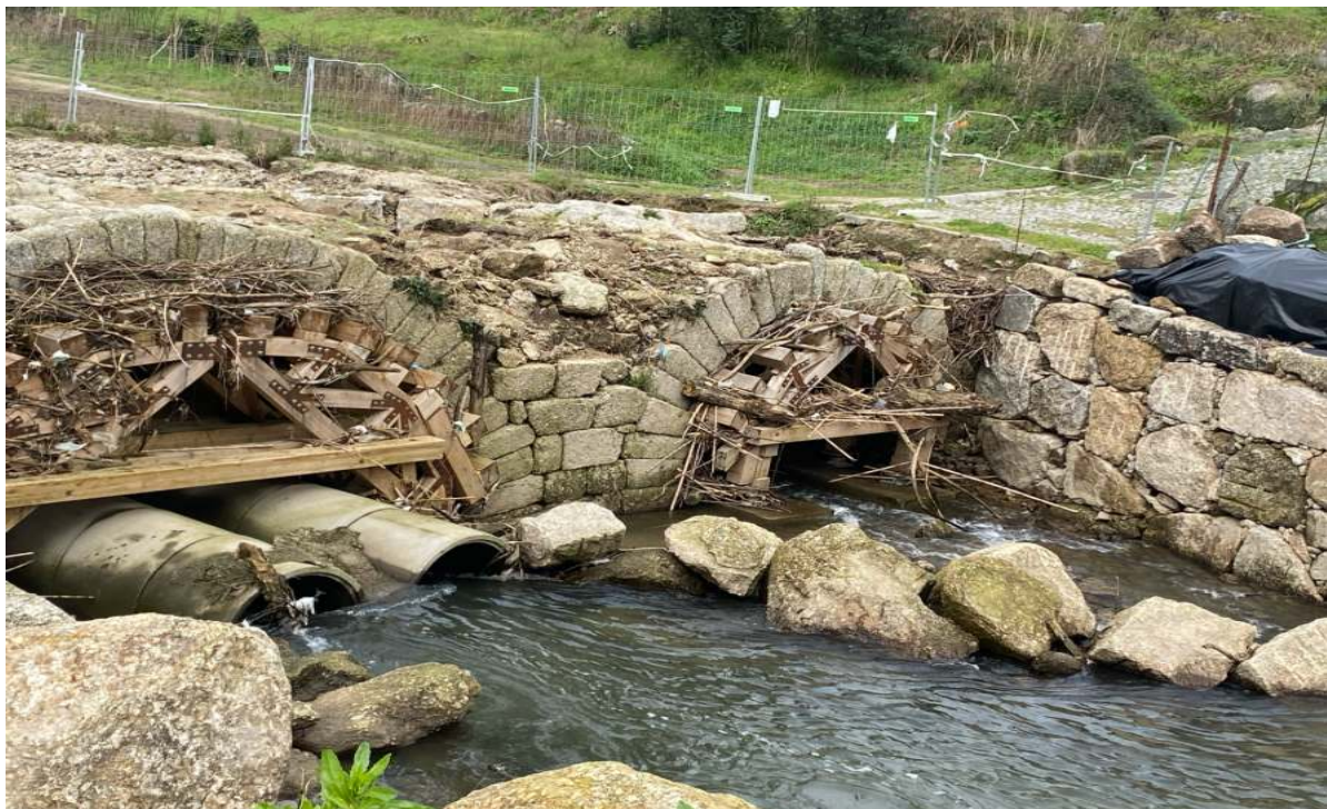
Figura 35 - P66: Deposição de detritos. Fonte: Autor.
