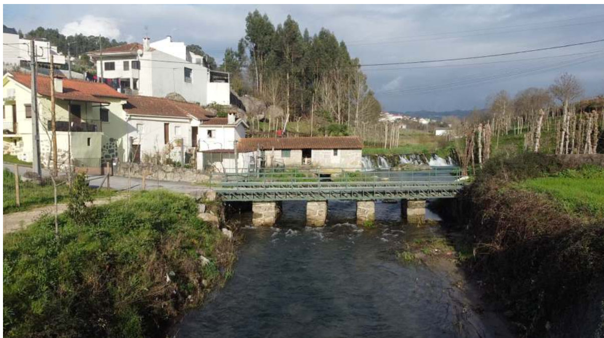
Figura 38 – P15: Estrutura física de ponte em viga. Fonte: Autor.
