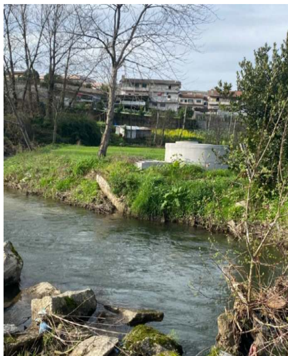
Figura 26 - Sistema de drenagem que inundava os campos. Fonte: Autor.
