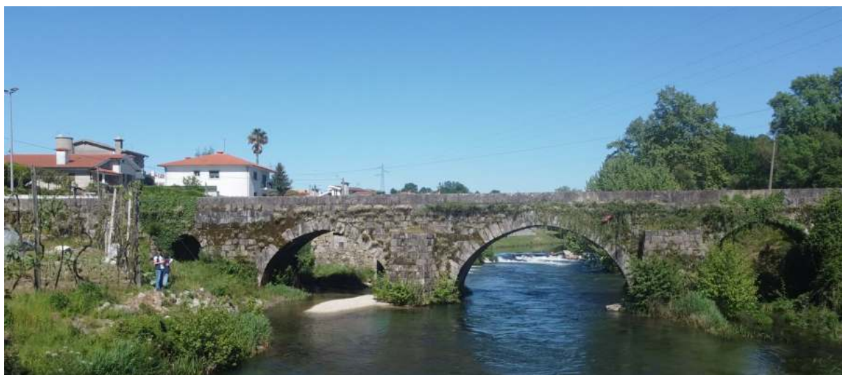
Figura 6 - Ponte de Donim, rio Ave. Fonte: Autor.
