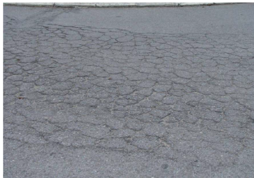
Figura 2.6 - Fendilhamento do tipo pele de crocodilo (Oliveira, 2013)
