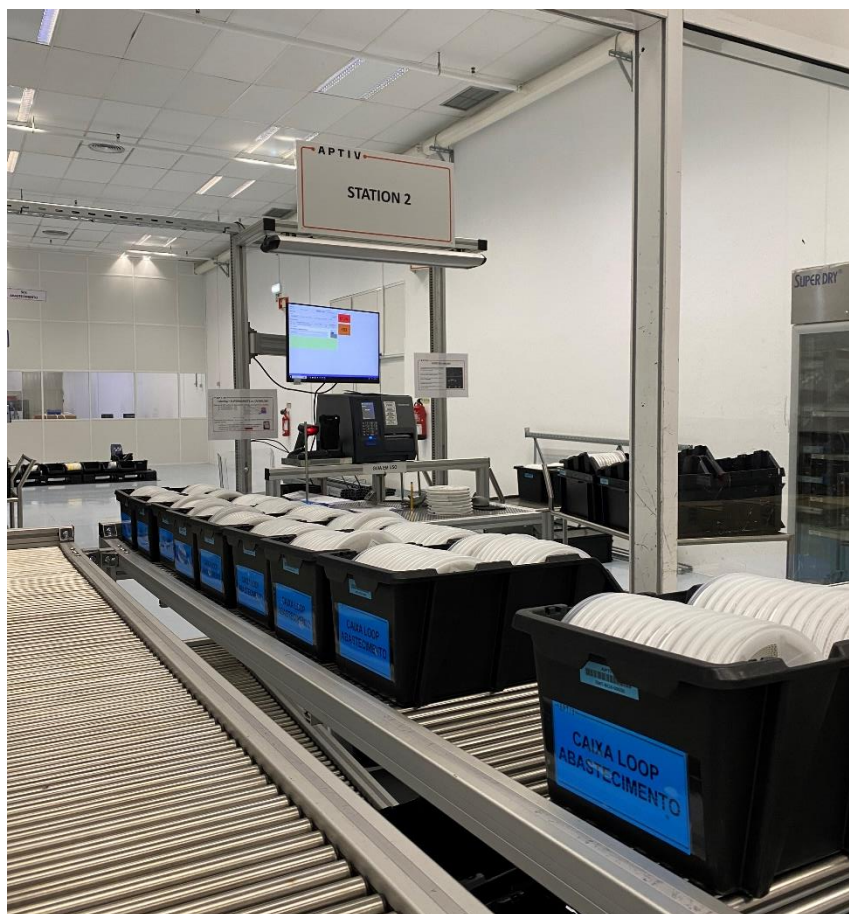
Figura 58: Conveyor abastecido com material
