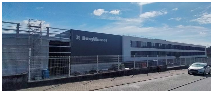
Figura 8: Instalações da BorgWarner Viana do Castelo.
