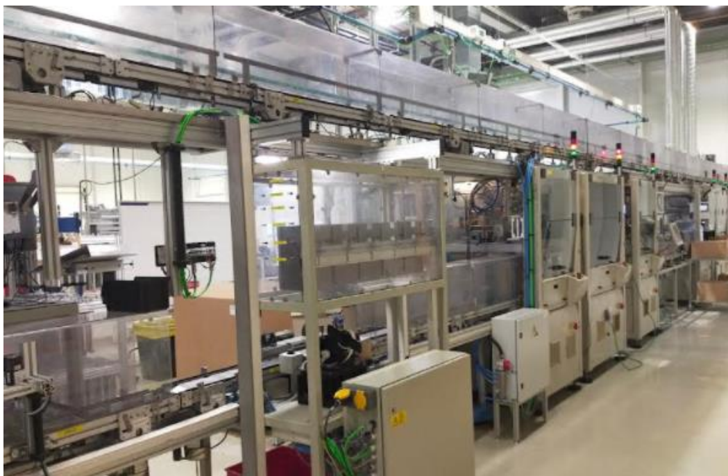
Figura 25: Linha Automatic Electronic Assembly (7H03-1).
