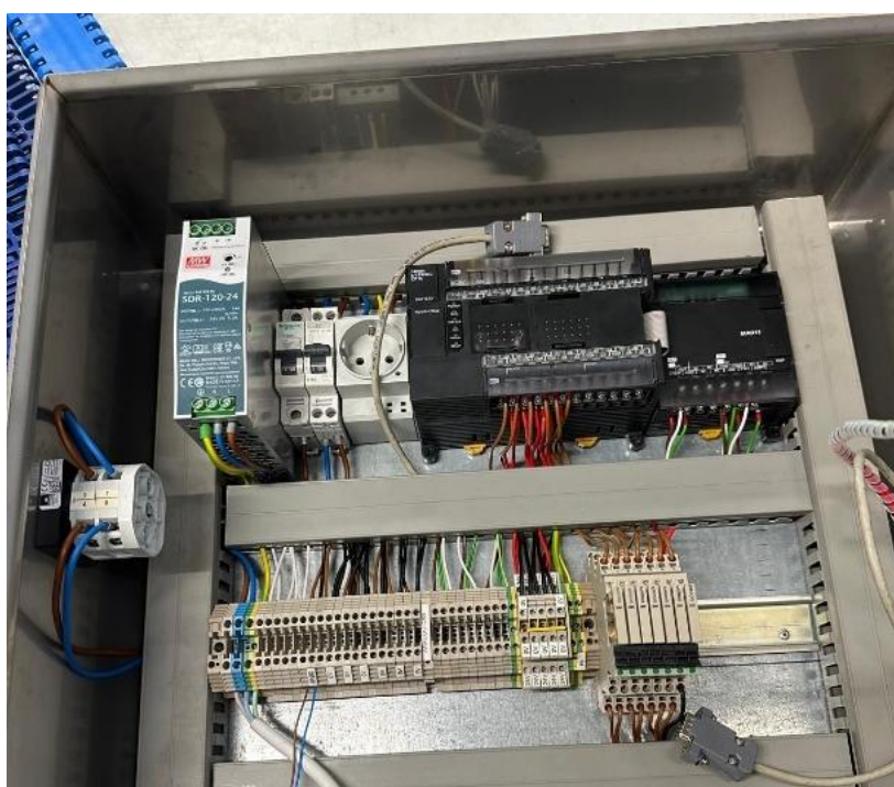
Figura 5.13 - Processo de montagem do quadro elétrico
