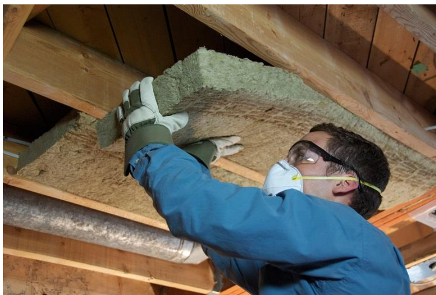
Figura 6 – Instalação de isolamento térmico com espumas poliméricas [7]
