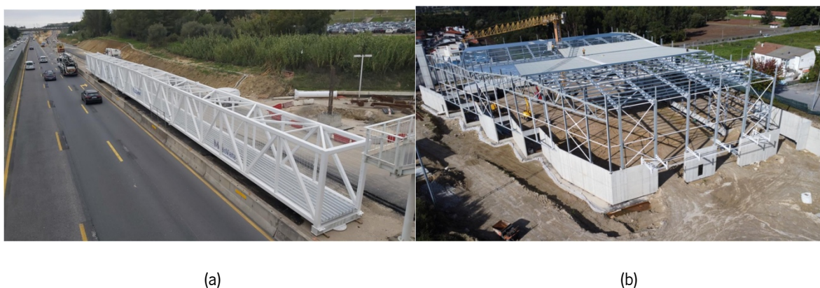
Figura 1 - (a) Passagem Pedonal – Via Rápida da Caparica; (b) Instalações – CLS Edifícios. [1]
