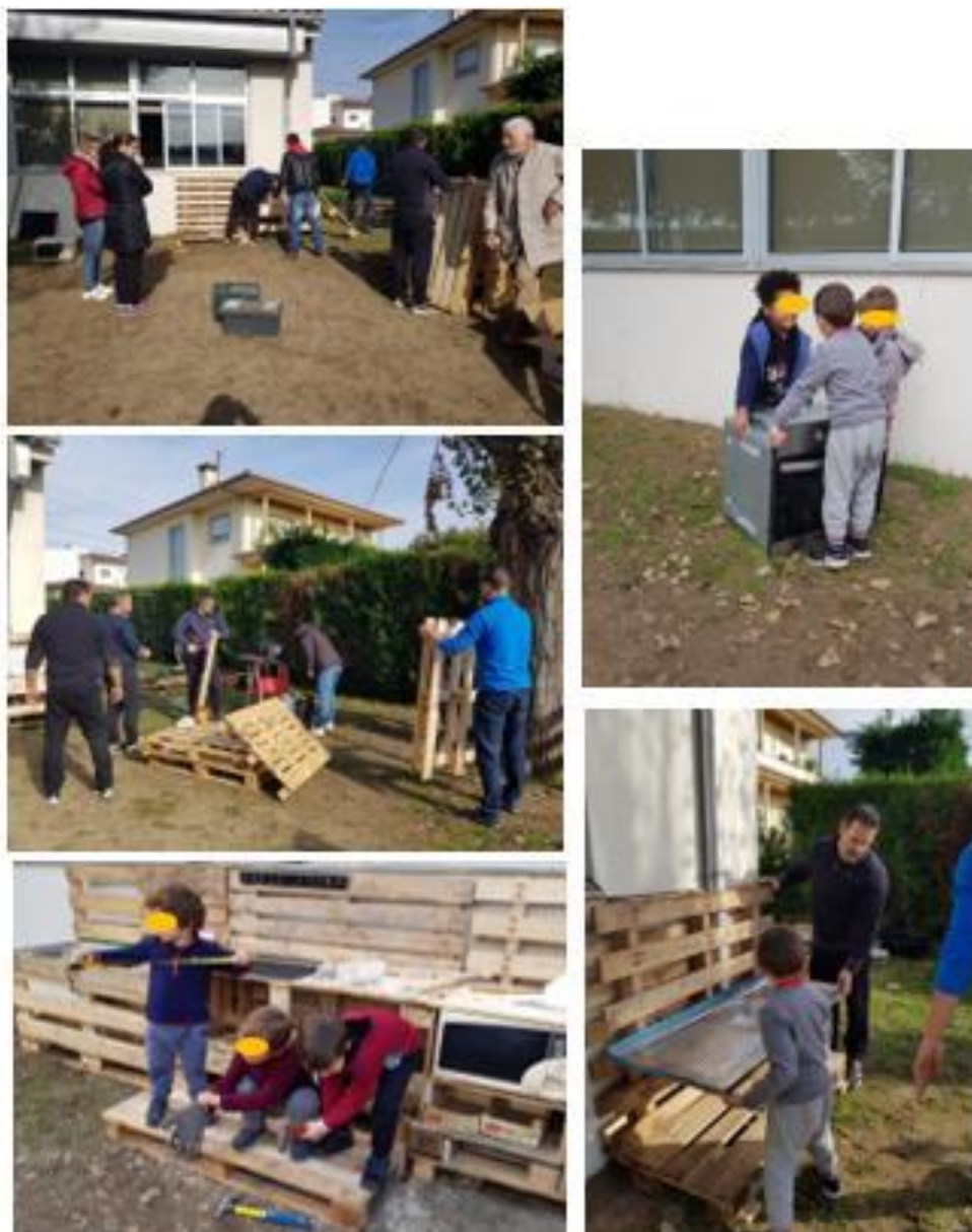
Figura 25 – Construção da cozinha de lama
