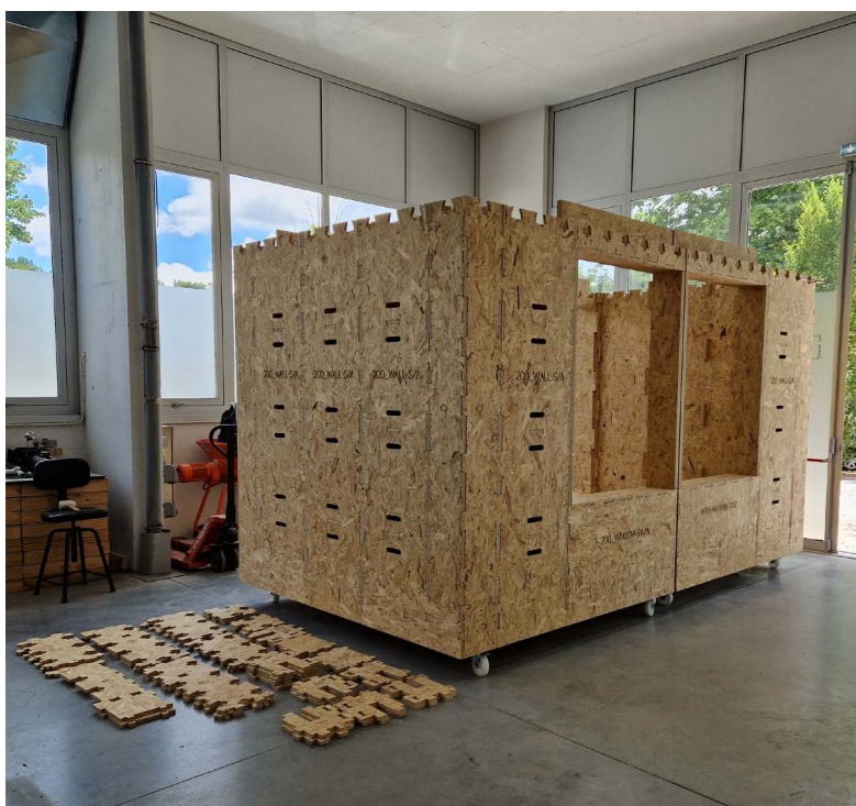
Fig. 3.2.15 - Etapas da montagem da estrutura. Fotos de RC.
