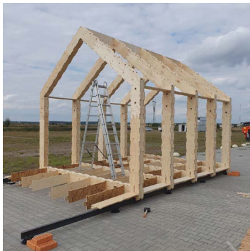
Fig. 1.4.4 - Estrutura utilizando o sistema WikiHouse Wren.
