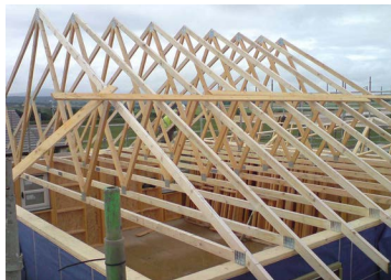
Fig. 2.2.15 - Treliças instaladas.
