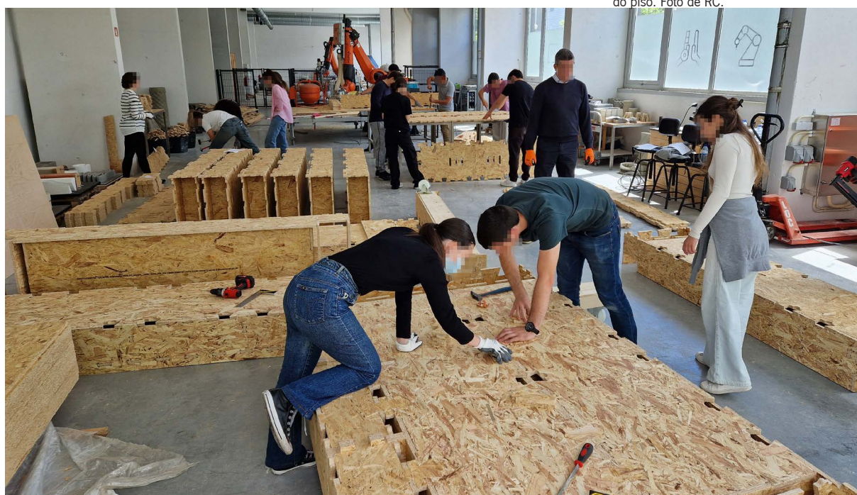
Fig. 3.2.13 - Estudantes montando a estrutura do piso. Foto de RC.
