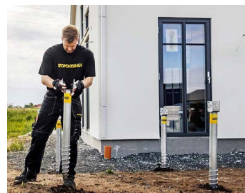
Fig. 2.2.11 - Estaca helicoidal sendo instalada.
