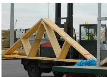
Fig. 2.2.16 - Treliças movidas por empilhadeira.
