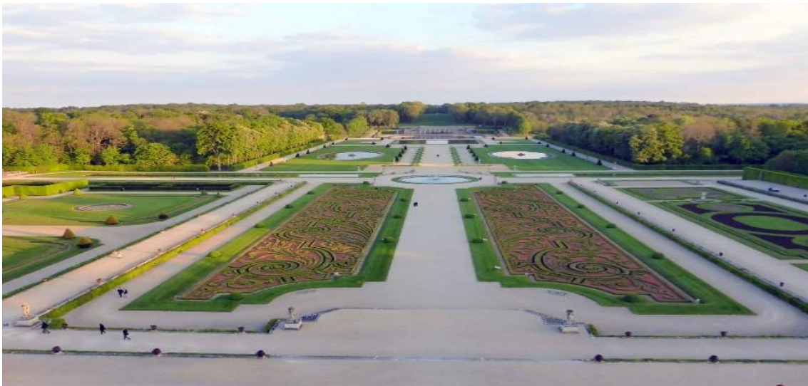
Figura 1 Vista do castelo de Vaux-le-Vicomte. Imagem retirada do website: https://www.moretimetotravel.com/ten-reasons-visit-chateau-de-vaux-le-vicomte/
