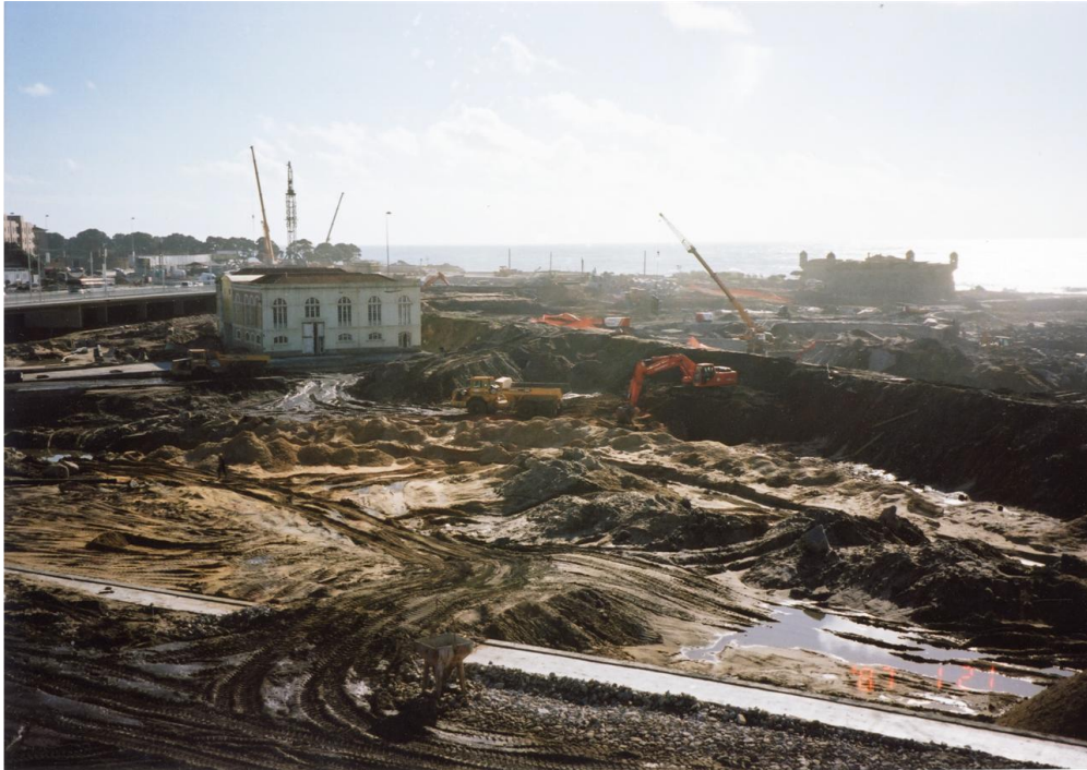
Figura 41. Foto das obras de restauração do terreno do Parque Ocidental da Cidade. Fonte: arquivo digital da CMP - https://gisaweb.cm-porto.pt/units-of-description
