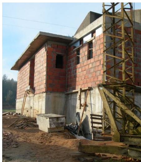
Figura 100 – Construção da moradia unifamiliar
