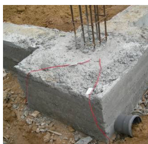
Figura 42 – Sensores aplicados “in situ” numa sapata
