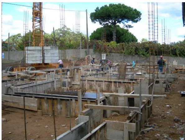
Figura 97 – Construção da escola
