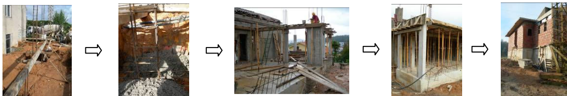
Figura 96 – As fases de construção
