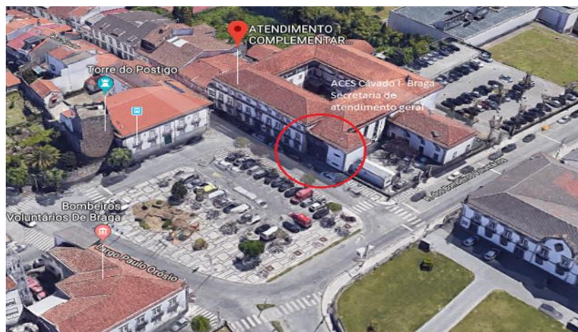
Figura 4- Largo Paulo Orósio; Edifício do ACES Cávado I- Braga.
