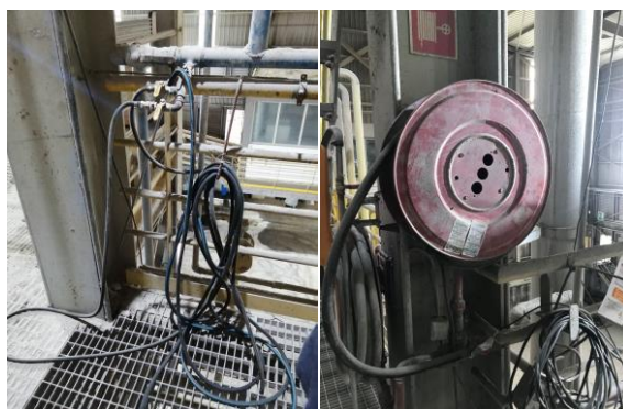
Figura 30-Situação inicial na plataforma intermédia
