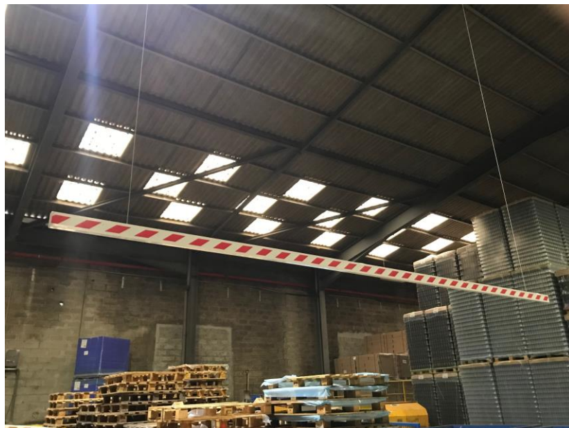
Figura 95-Colocação de cabo de aço para limitar altura máxima dos estrados
