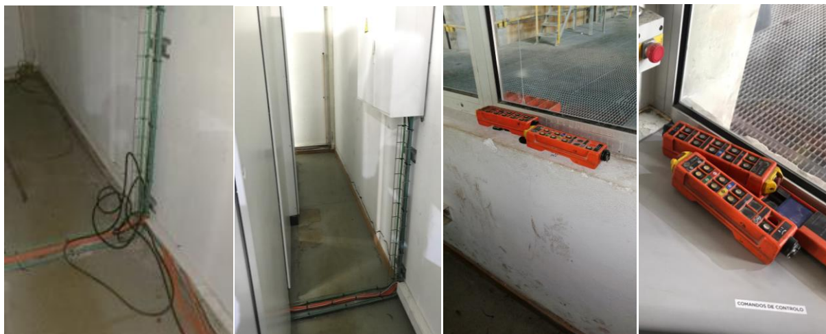
Figura 62-Soluções implementadas para arrumação da cablagem e gestão visual de consumíveis
