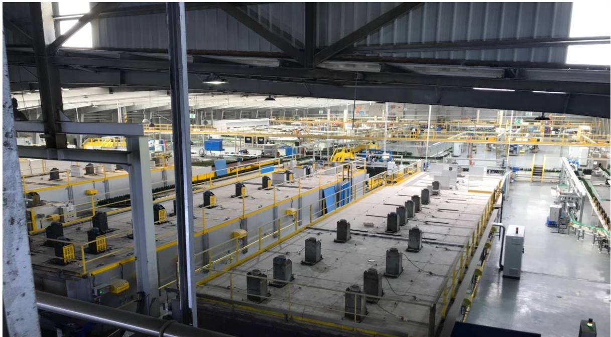
Figura 18-Vista superior do AV5
