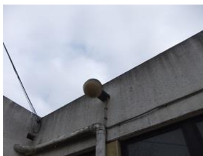
Figura 38 – Exemplo de Iluminância presente no exterior do edifício, neste caso, uma luminária de uma lâmpada de VM [49].
