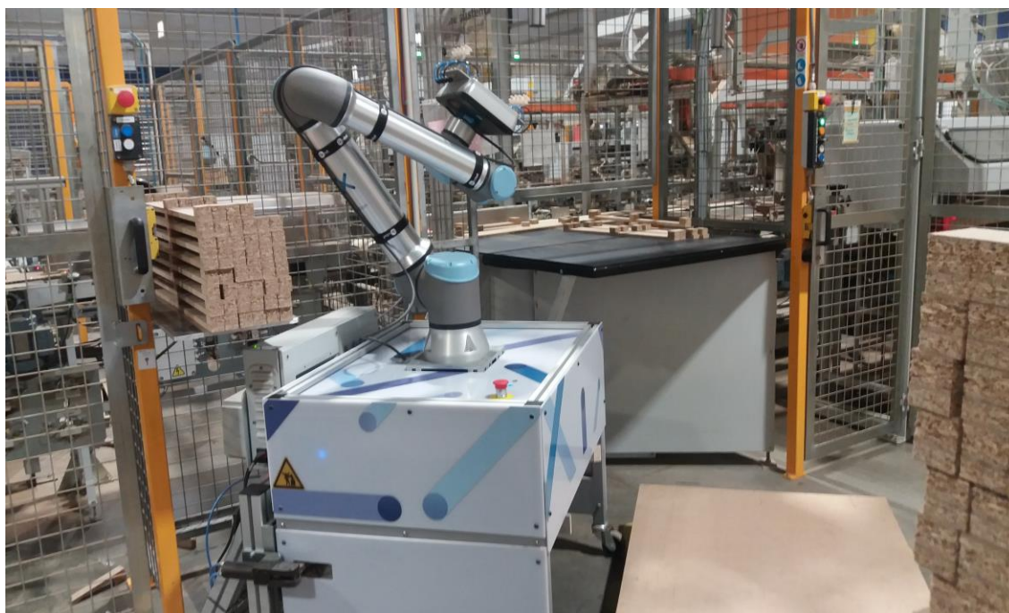
Figura 16 – Robô colaborativo que foi instalado
