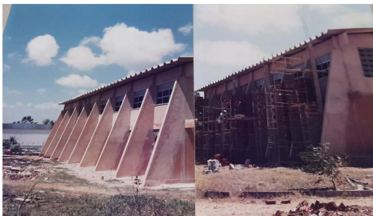
FIGURA 04 – CONSTRUÇÃO DO LABORATÓRIO DE ESTRADAS (1988)
