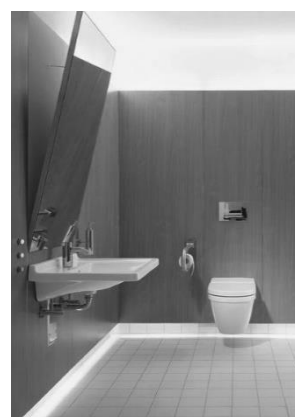
Figura 17. Sanita e lavatório.
