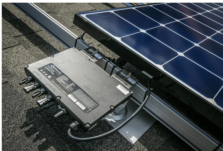
Figura 6 – Micro-inversor fotovoltaico (Paulo 2019)
