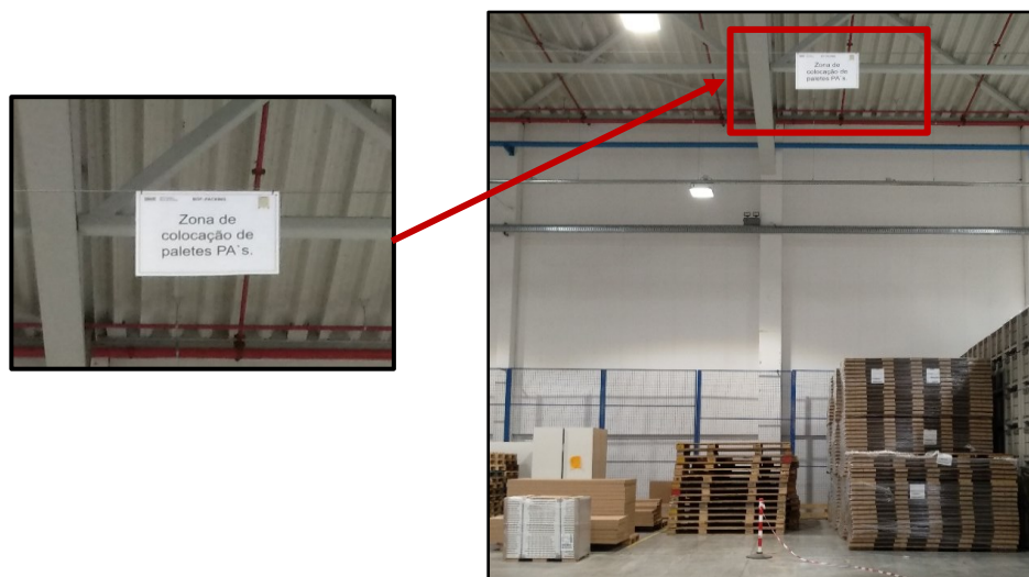
Figura 143 - Zona destinada à colocação das paletes de PA's
