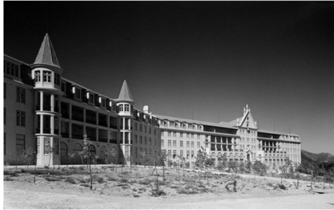
Figure 8: Penhas da Saúde Sanatorium, Serra da Estrela, Portugal, 1940
