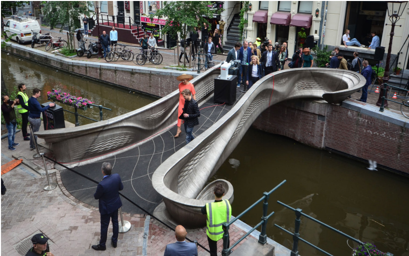
Figura 3.5.11. Imagem da ponte desenhada e fabricada pelo estúdio MX3D com recurso a técnicas de deposição de metal com recurso a um braço Robótico. Fonte: https://mx3d.com/industries/infrastructure/mx3d-bridge/
