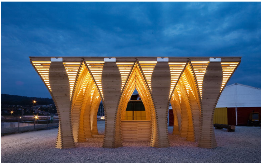
Figura 8.1.6. Vista geral do Pavilhão. Fonte: http://blog.fabric.ch/index.php?/archives/612-Gramazio-Kohler-Installation-West-Fest-Zuri-ch.html
