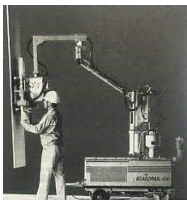
Figura 3.3.1 Robot japonês, Boardman-100 a dar apoio à colocação de placas numa construção. Fonte: Mason, Molly. (2015)
