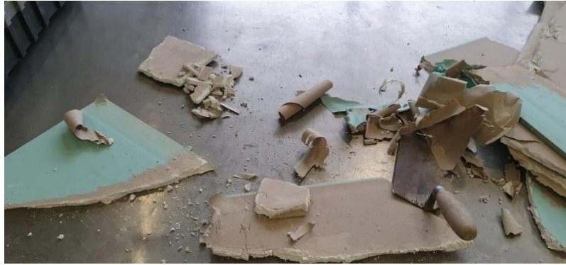
Figura 15 Placa de gesso partida em frações mais pequenas
