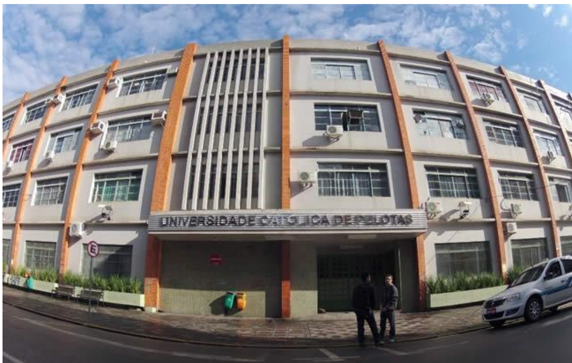
Figura 21 - Fachada Principal do Campus I da Universidade Católica de Pelotas (Universidade Católica de Pelotas, s.d.)
