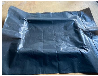
Figura 30 – colocação da lona
