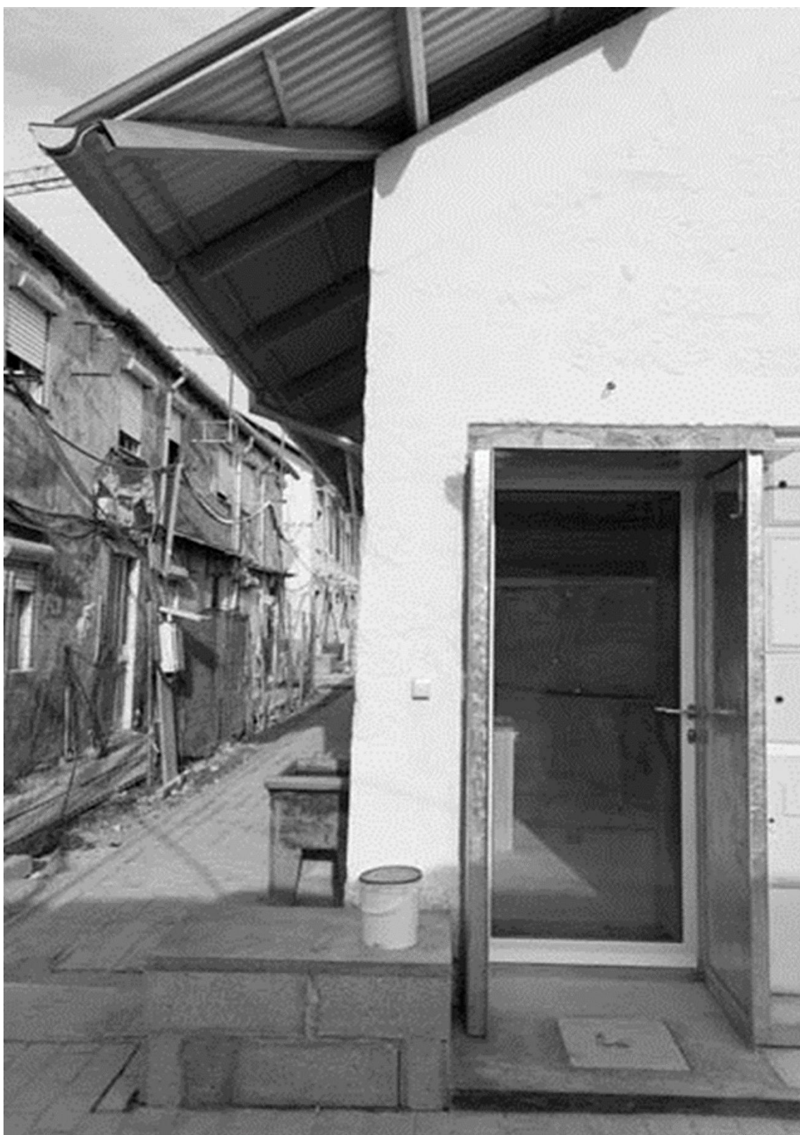
[Figura 67.] Ilha da Bela Vista durante a reabilitação. (Escritório Cerejeira Fontes, 2014)
