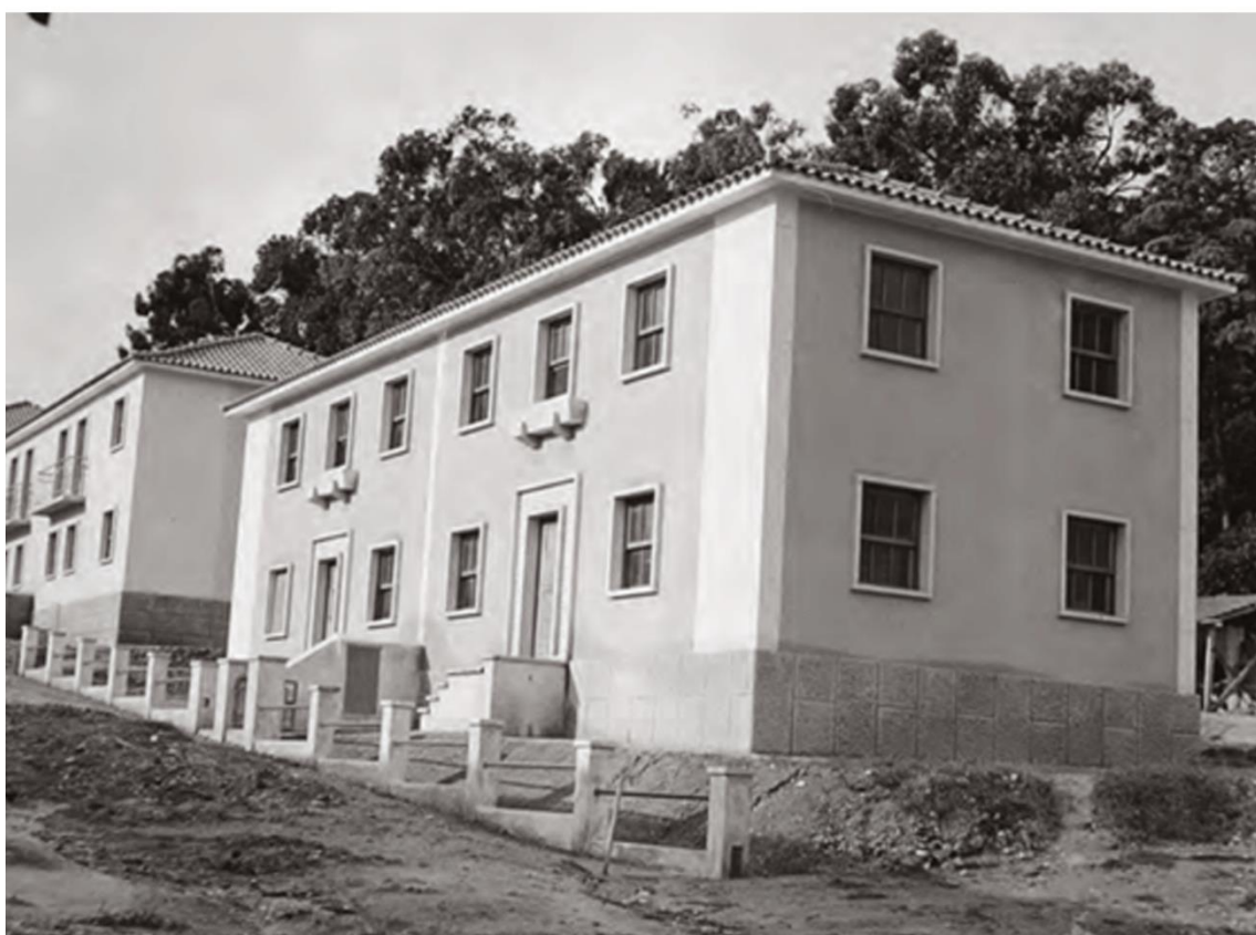
[Figura 9.] Bairro de Casas Económicas de Benfica ou de Santa Cruz, em construção, Lisboa, 1956 (Arquitetos Keil do Amaral e João Vaz Martins para a DGEMN, 1943–1958). SIPA/DGEMN. (Pereira & Silva, 2018)
