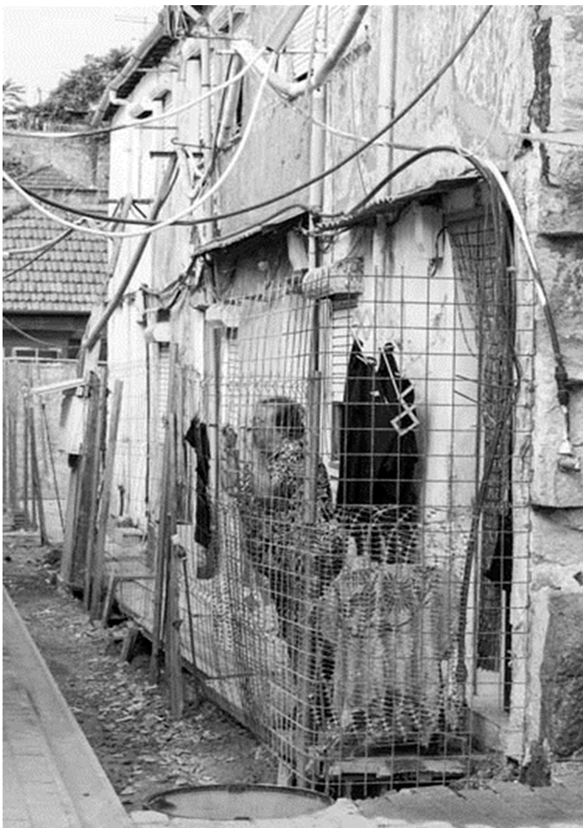
[Figura 66.] Habitações da Ilha da Bela Vista durante o processo de reabilitação, aquando da demolição de habitações para a criação de percursos dentro da ilha. (Escritório Cerejeira Fontes, 2014)
