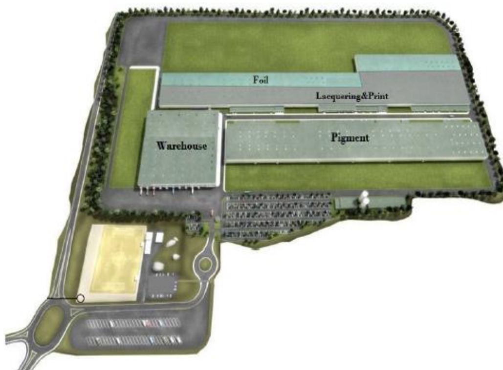
Figura 16 - Instalações IKEA Industry Portugal .
