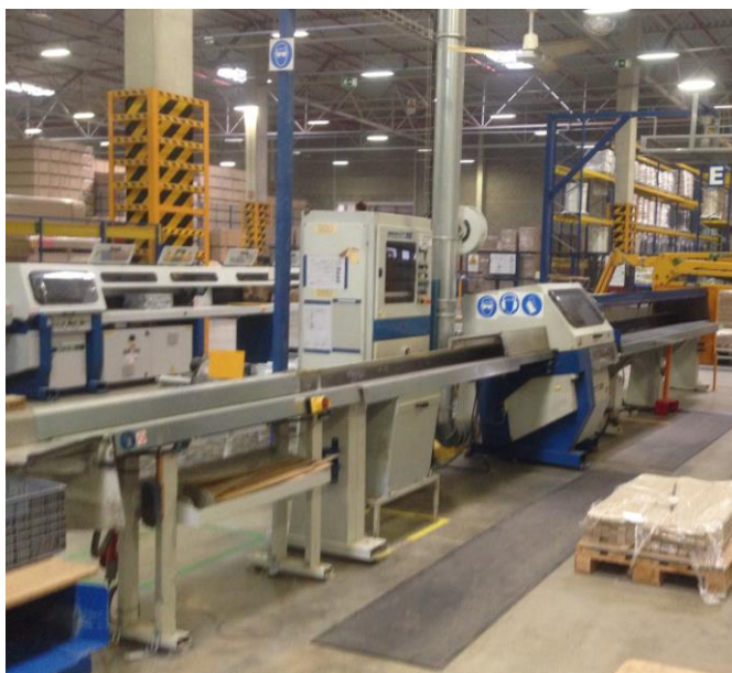
Figura 27 - Esquartejadora para corte de material.
