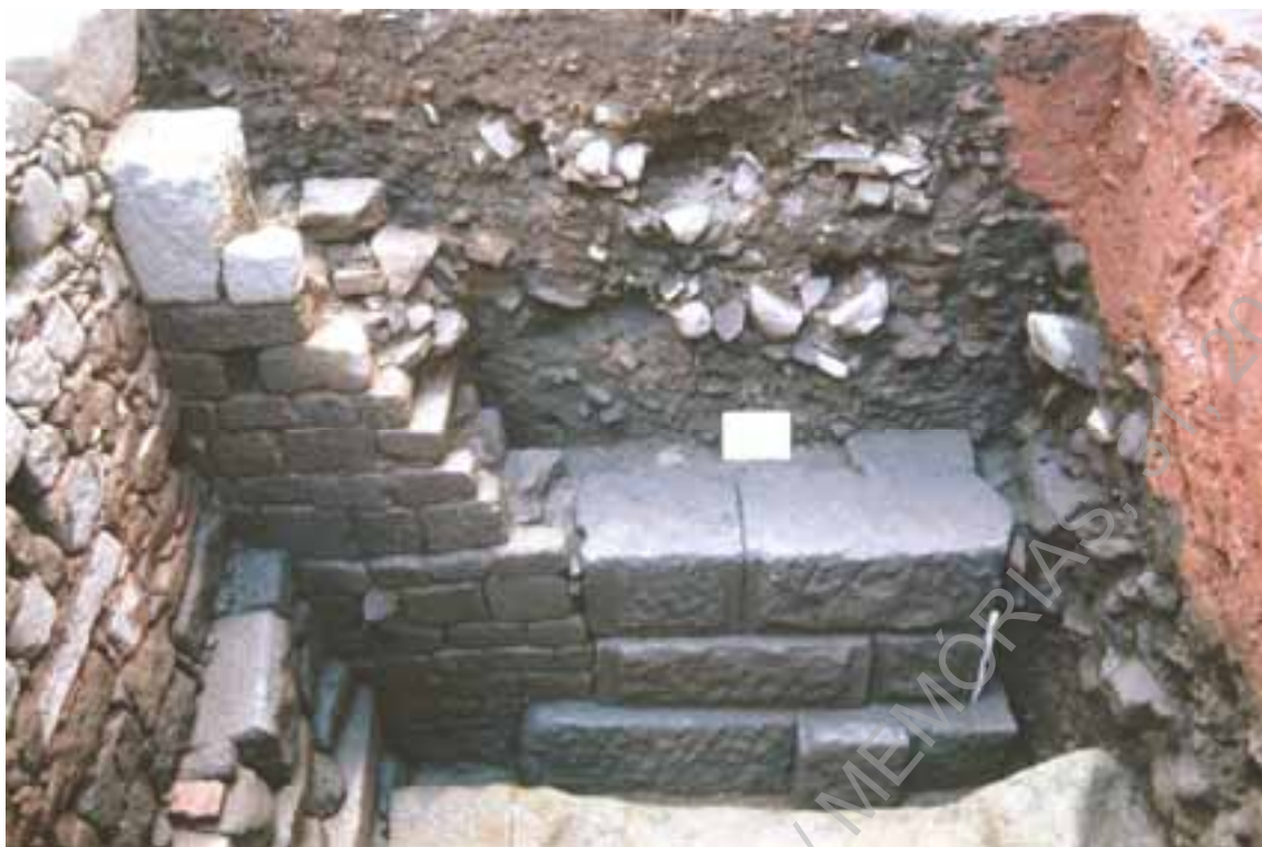
Sector C1. Alçado Oeste do muro 2. 1ª campanha.
