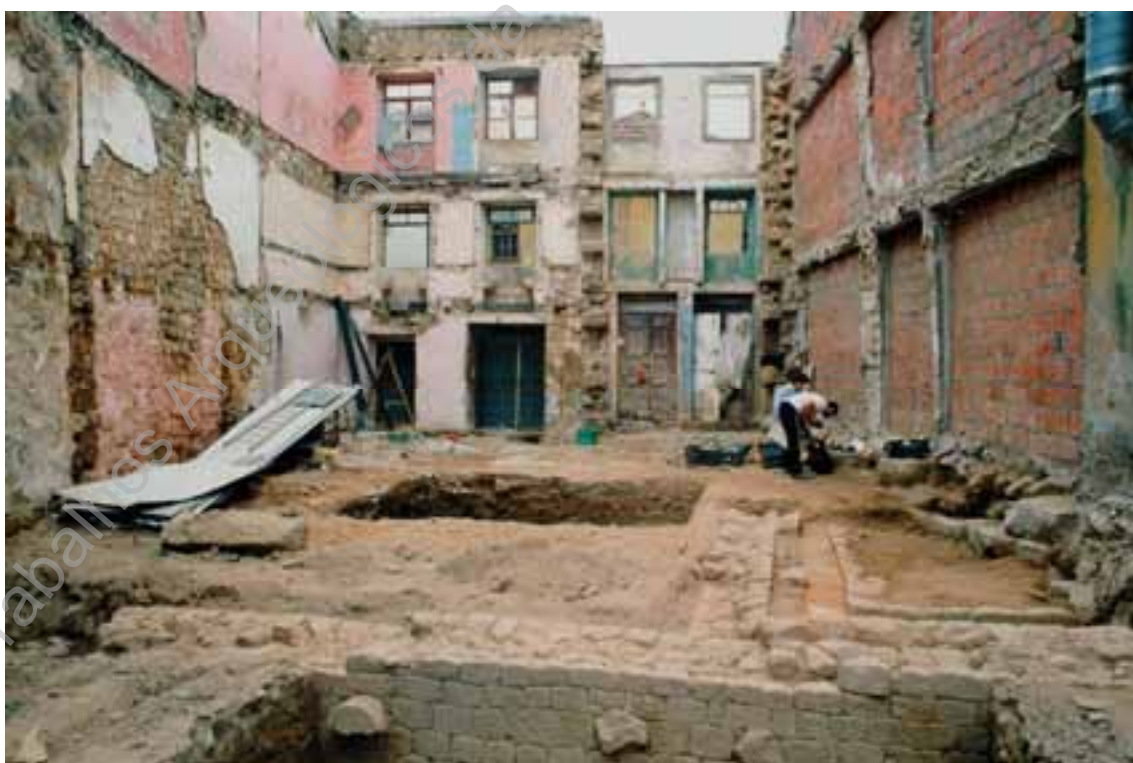
Aspecto geral pós-demolição do interior do edifício; orientação O/E. 1ª campanha.
