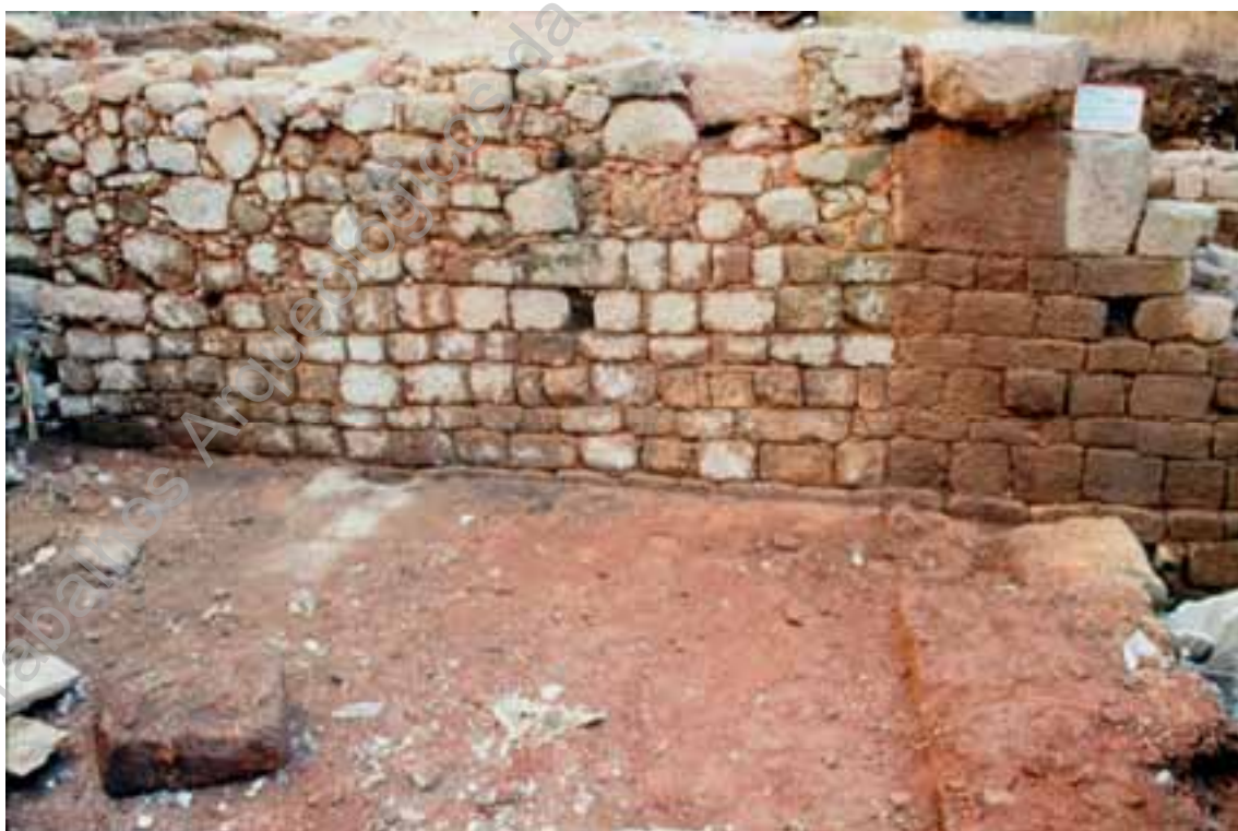
Sector C/2.3. Alçado dos mesmos muros, após picagem do reboco. 2ª campanha.
