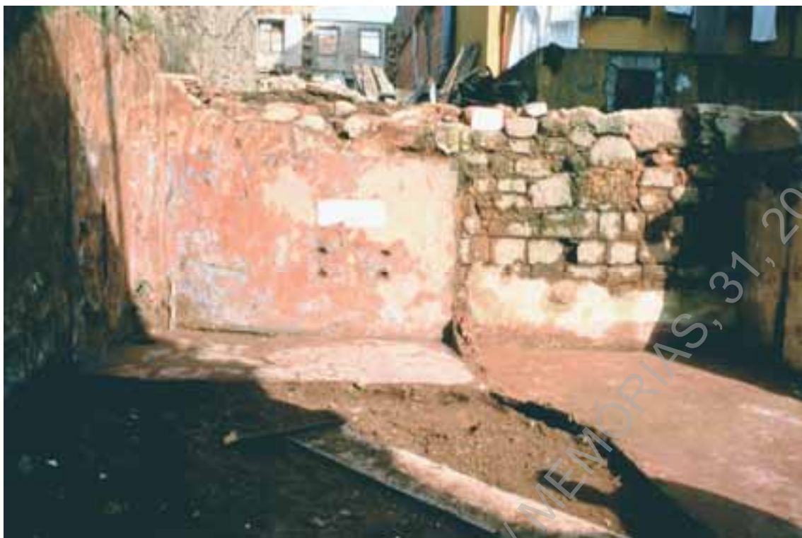
Sector C/2.3. Alçado Oeste dos muros 2 e 8 rebocados no séc. XIX. 2ª campanha.
