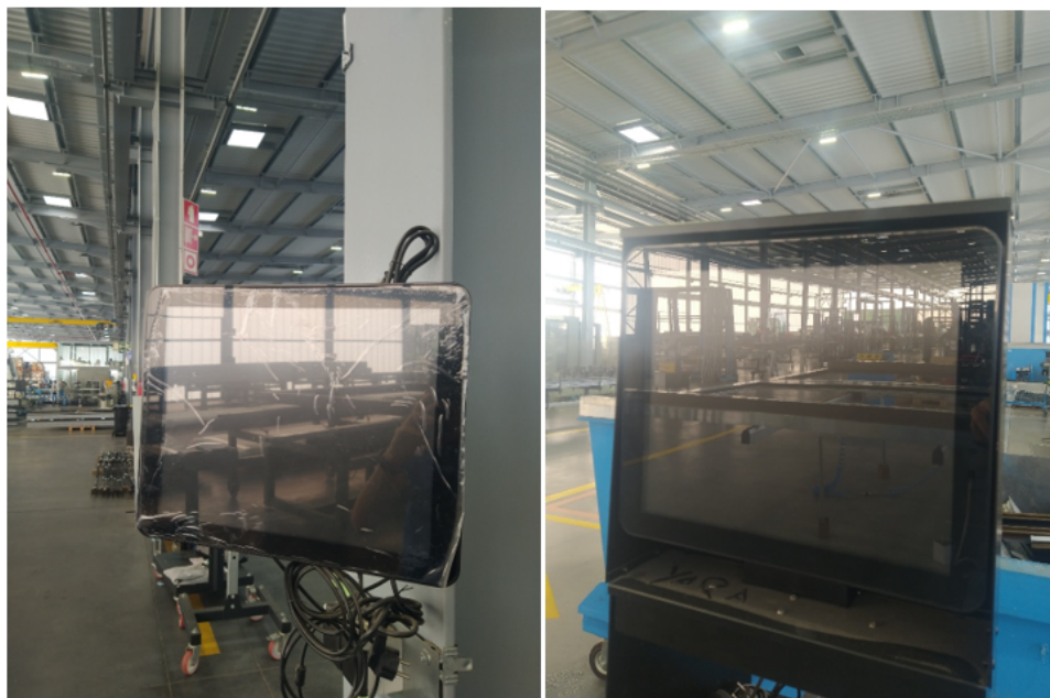
Figura 34: Monitores táteis no chão de fábrica
