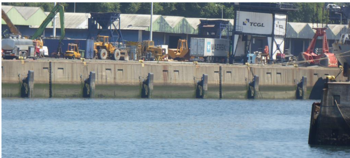
Figura 29. Doca 4, com defensas tipo célula, semi-submersas, e cabeços de amarração (fotografia oferecida pela APDL).
