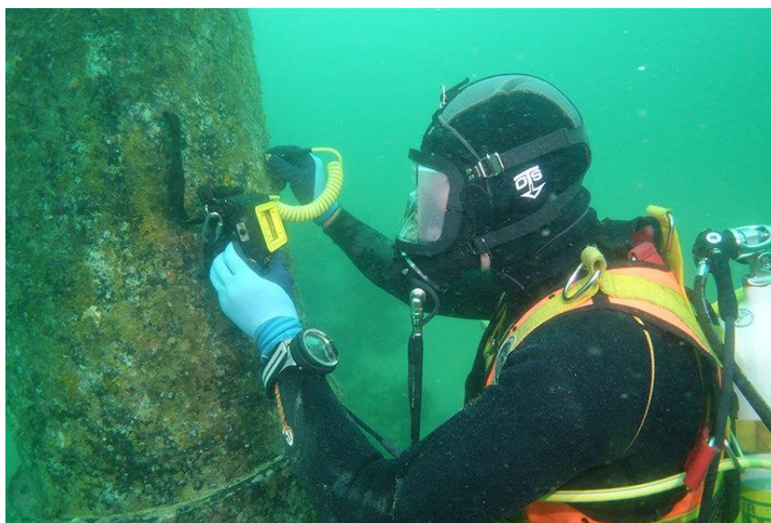
Figura 19. Medição realizada por mergulhador em inspeção subaquática [71].
