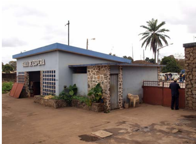
Figura 4.31 - Portão de acesso à Sala de Espera. (EM, 2010)
