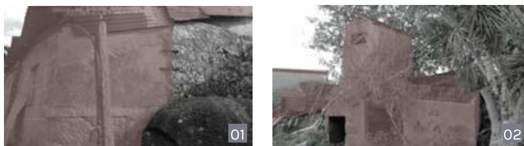
FIG. 69| Registo fotográfico com anotações de construções a demolir (1,2,3,4,5) - referente à Planta 2
