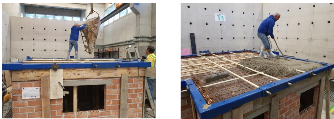
Figura 56 - Betonagem e vibração da laje
