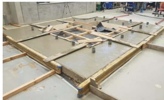
Figura 51 - a) Betonagem e vibração da fundação, b) conclusão da betonagem da fundação
