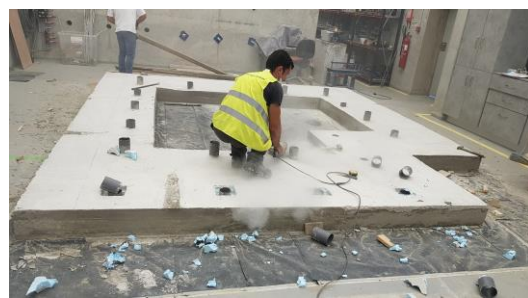
Figura 52 - a) Descofragem, b) corte/ajuste dos tubos de PVC em altura
