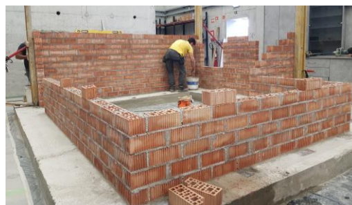
Figura 53 - a) Posicionamento da 1ª fiada de unidades, b) elevação das paredes
