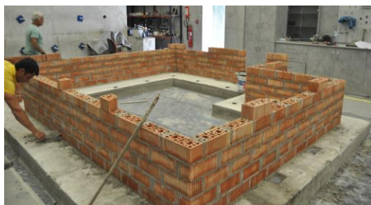
Figura 53 - a) Posicionamento da 1ª fiada de unidades, b) elevação das paredes
