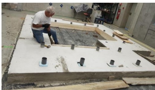
Figura 52 - a) Descofragem, b) corte/ajuste dos tubos de PVC em altura
