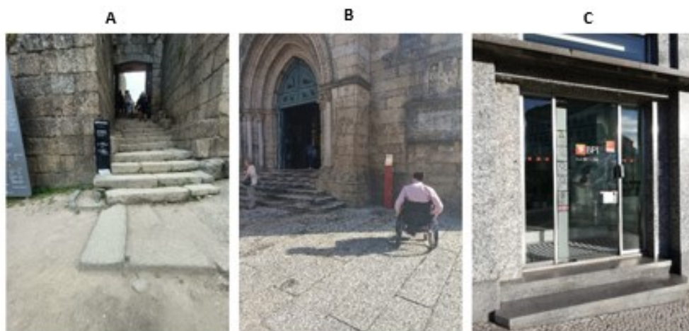
A. Entrada do Castelo de Guimarães; B. Entrada da Igreja da Oliveira; C. Entrada do Banco BPI
