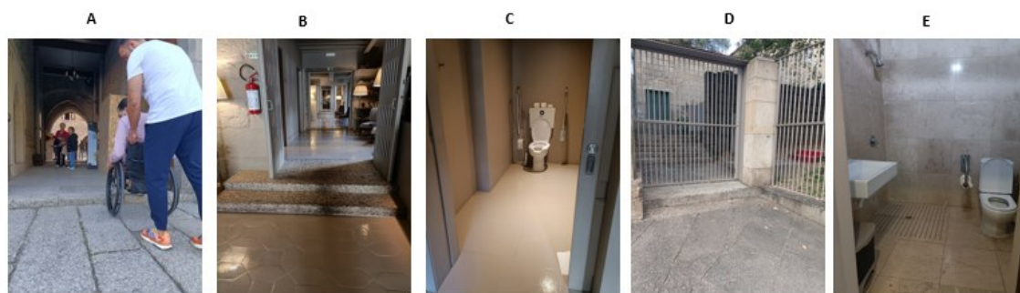
A. Entrada do Paço dos Duques de Bragança; B. Acesso ao WC do restaurante Holl; C. WC adaptado do restaurante Holl; D. Entrada lateral do Museu Alberto Sampaio; E. WC adaptada do Museu Alberto Sampaio
