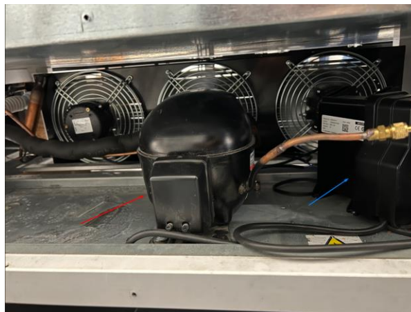
Figura 23: Conjunto compressor, indicado através da seta vermelha, e inversor, indicado através da seta azul.
