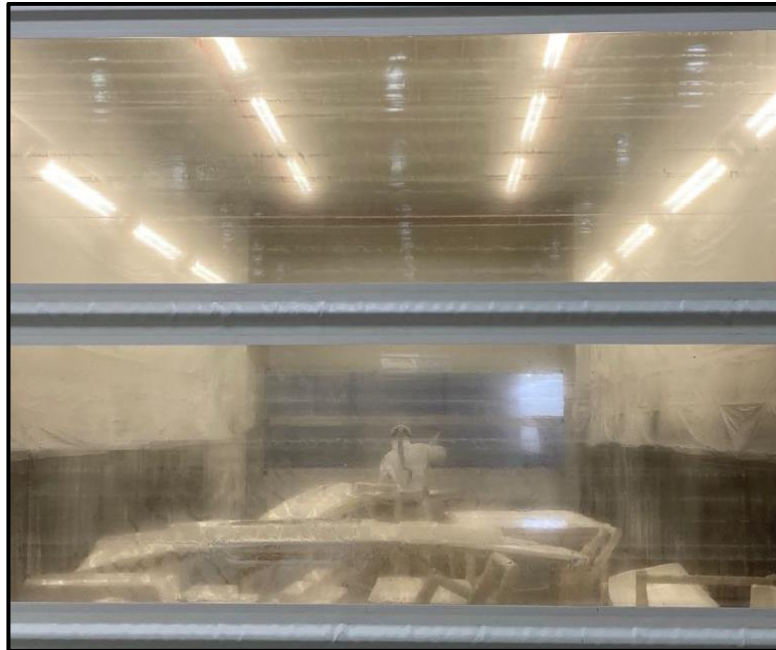
Figura 19. Cabine de pintura
