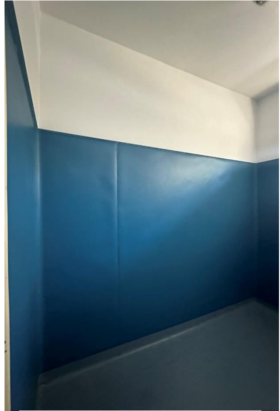
Figura 3.2.14. Interior da Sala de Isolamento 1 (Piso Térreo).
