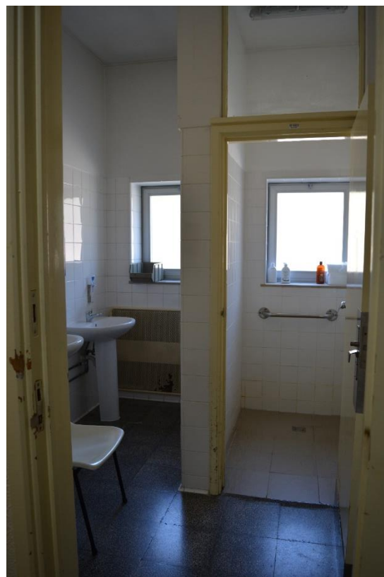
Figura 3.2.30. Instalações Sanitárias, Zona Feminina (Piso 1).
