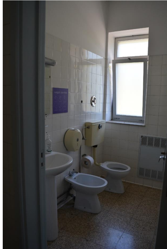
Figura 3.2.54. Instalações Sanitárias Privadas, Zona Masculina (Piso 1).
