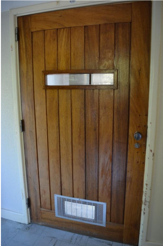
Figura 3.2.37. Sala de Isolamento 2 (Piso 1).
