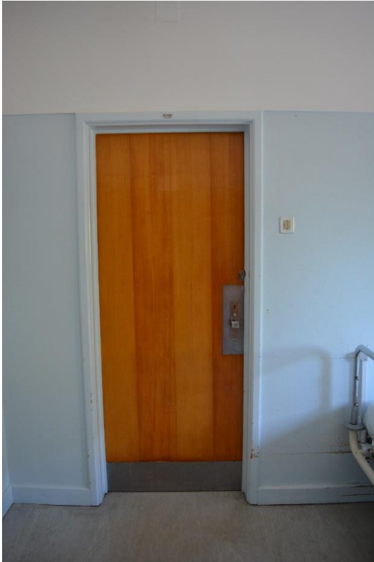
Figura 3.2.53. Entrada para as Instalações Sanitárias Privadas, Zona Masculina (Piso 1).
