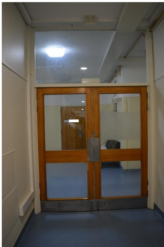
Figura 3.2.12. Porta de Acesso ao Hospital de Dia (Piso Térreo).
