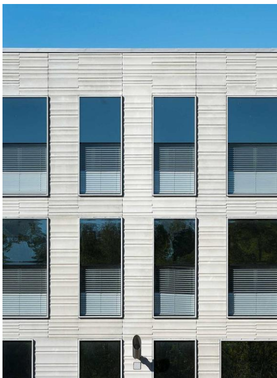
Figura 2.4.3.1.1. Pormenor da fachada do edifício.
