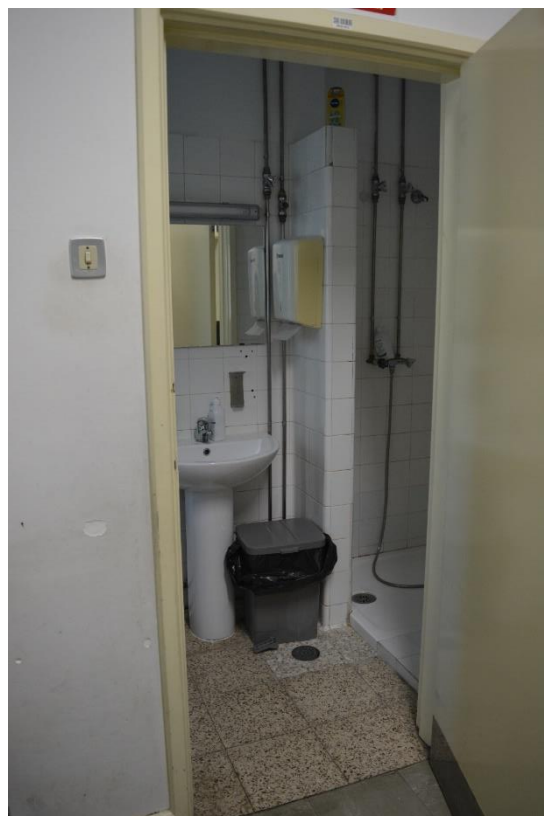
Figura 3.2.42. Instalações Sanitárias, Zona Feminina (Piso 1).
